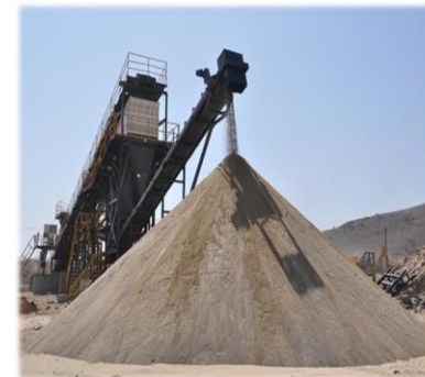
Slag Sand Plant
