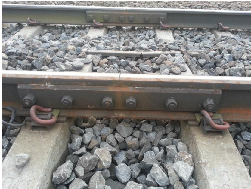
Figur 22. En limmad 6-håls isolerskarv på Malmbanan.
