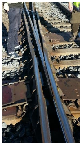
Figur 23. En växel med rörlig korsningsspets.
