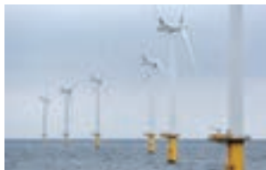
Luchterduinen offshore wind farm
