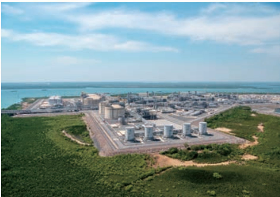
Ichthys LNG Project Onshore LNG Plant
