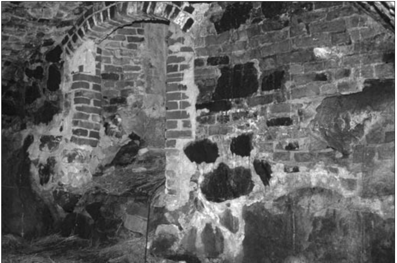
Ikkuna on nykyään oviaukko portaineen.
