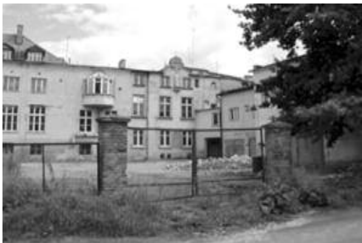
Rys. 11. Stan obiektów przed rozpoczęciem prac Źródło: http://www.miastochojnice.pl/foto/3482.jpg
