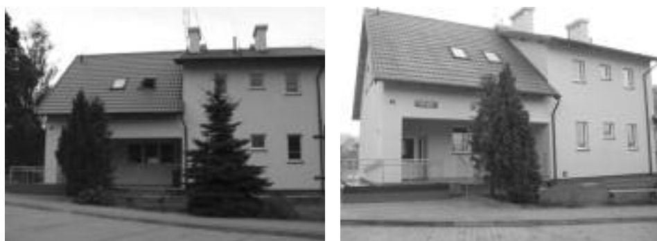
Rys. 3. Zdjęcia z realizacji inwestycji – remontu budynku biblioteki w Męcikale z poszerzeniem oferty o czytelnię z pracownią komputerową oraz punktem informacji turystycznej
