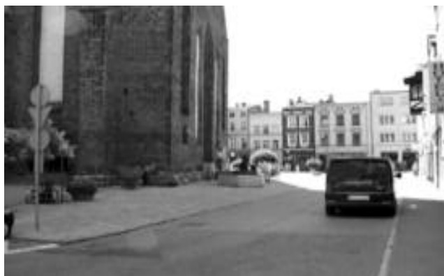
Rys. 4. Otoczenie Bazyliki Mniejszej przed rozpoczęciem prac Źródło: http://www.miastochojnice.pl/?a=158&id=3772#
