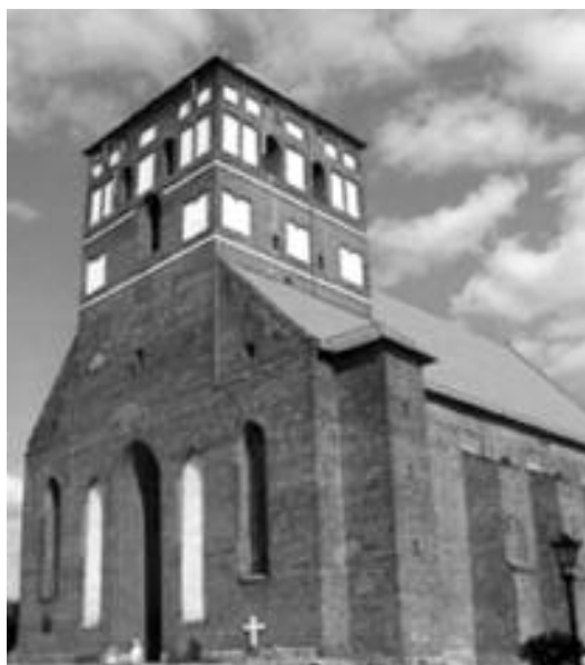
Rys. 3. Bazylika Mniejsza w Chojnicach przed remontem Źródło: http://promocja.chojnice.pl/?a=5&&id_kat=22&id_fot=52
