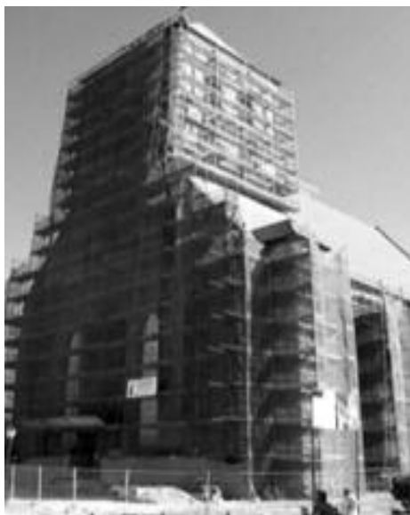
Rys. 1. Trwające prace renowacyjne na Bazylice Mniejszej w Chojnicach
