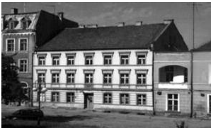
Rys. 12. Siedziba obecnego Miejskiego Ośrodka Pomocy Społecznej w Chojnicach przed rewitalizacją
