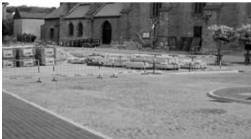
Rys. 2. Prace budowlane prowadzone w otoczeniu Bazyliki Mniejszej w Chojnicach
