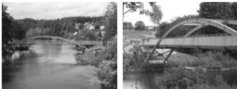
Rys. 2. Realizacja inwestycji „Rewitalizacja historycznego układu przestrzennego Męcikała sposobem na wzrost atrakcyjności turystycznej i poprawę bezpieczeństwa miejscowości”
