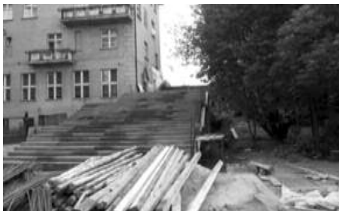
Rys. 9. Budowa schodów łączących zrewitalizowany obszar z centrum miasta
