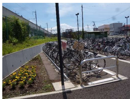
駐輪場の新設（IGRいわて銀河鉄道 厨川駅）
