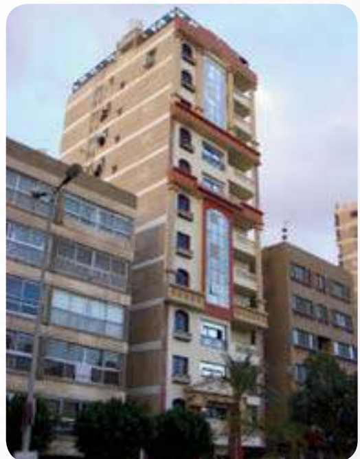
Bangunan Asrama Darul Aman (3) di Hayyu Sabie'
