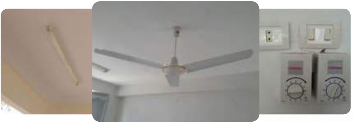
Pemasangan kipas, lampu dan pendawaian baru
