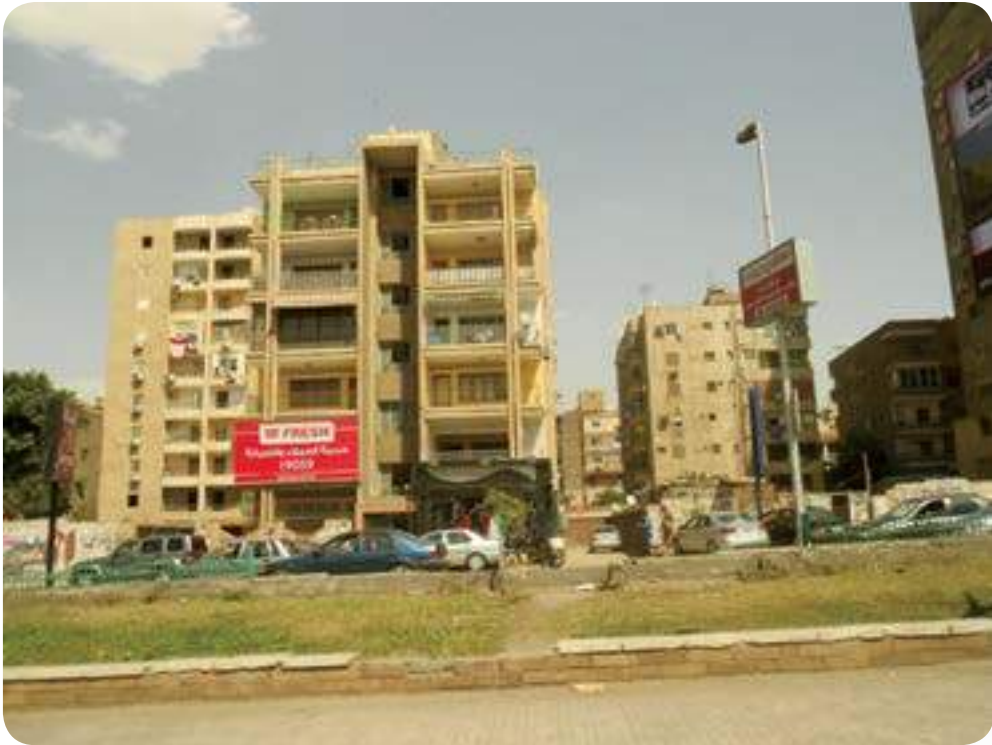
Bangunan Rumah Pahang di Abbas al-Akkad
