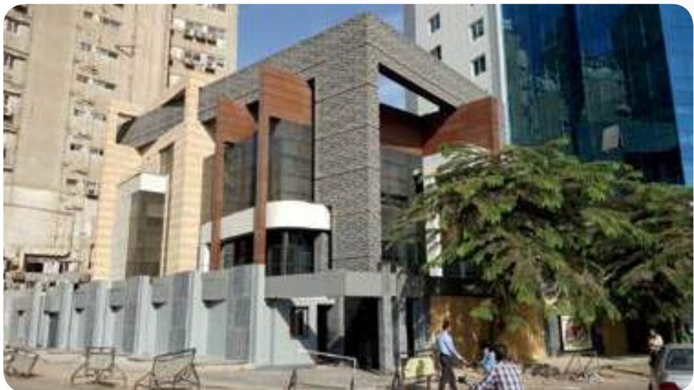
Bangunan rumah Malaysia sewaktu proses baik pulih peringkat akhir dibuat pada Disember 2018
