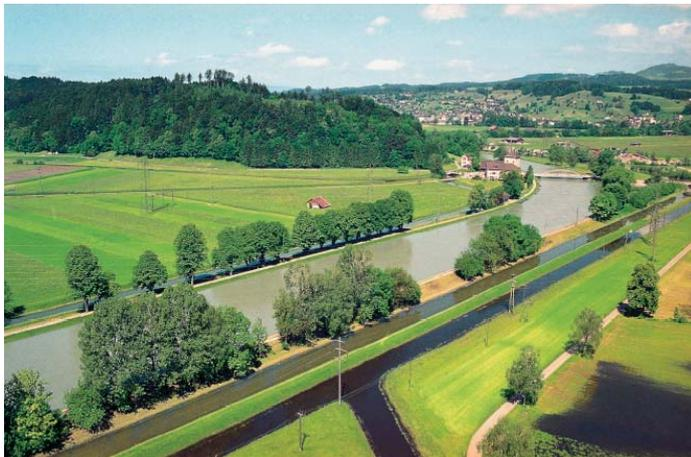
**Abb. 3:** Das System des Linthkanals an seiner Belastungsgrenze. Das Bild vom Maihochwasser 1999 zeigt das komplexe System des Linthwerks mit seinen drei hydraulischen Stockwerken. Der Linthkanal ist flankiert von den beiden tieferliegenden Hintergräben. Im Vordergrund verläuft der noch tiefer liegende Meliorationskanal.
