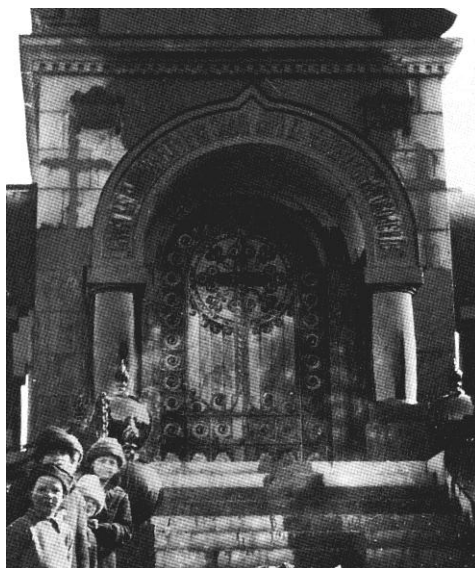
Kuva 126. Kappelin pohjoisen sisäänkäynnin yksityiskohtainen koristelu.
