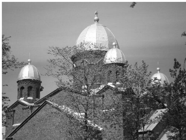
Kuva 131. Lappeenrannan kirkon kattoa vuonna 2008 uusituilla kupoleillaan.
