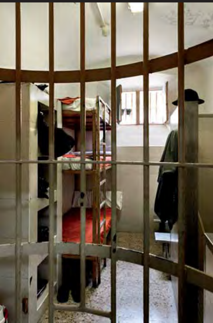
Aquesta reixa corbada es coneix com el cangrejo i aporta doble seguretat amb la porta de ferro exterior a les cel·les dels presoners més perillosos.
