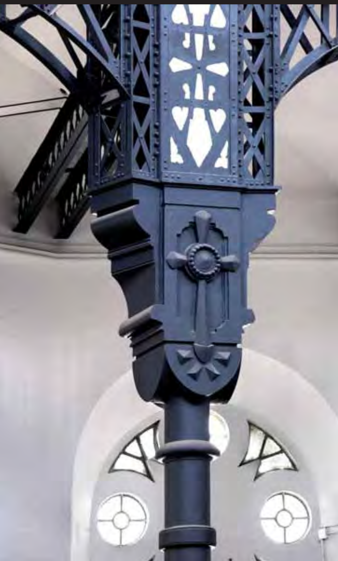
Capitell de ferro forjat amb una creu. És un element original de la construcció de l'edifici l'any 1904.
