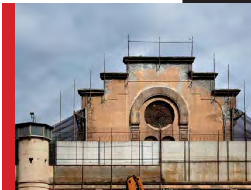
Garita de vigilància del perímetre exterior de la presó i mur protector elevat per mitigar els sorolls de la presó cap a l’exterior i per evitar el llançament d’objectes dins del recinte.
