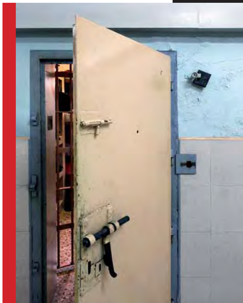
Les cel·les de la sisena galeria tenen doble porta de ferro i reixes per més seguretat.
