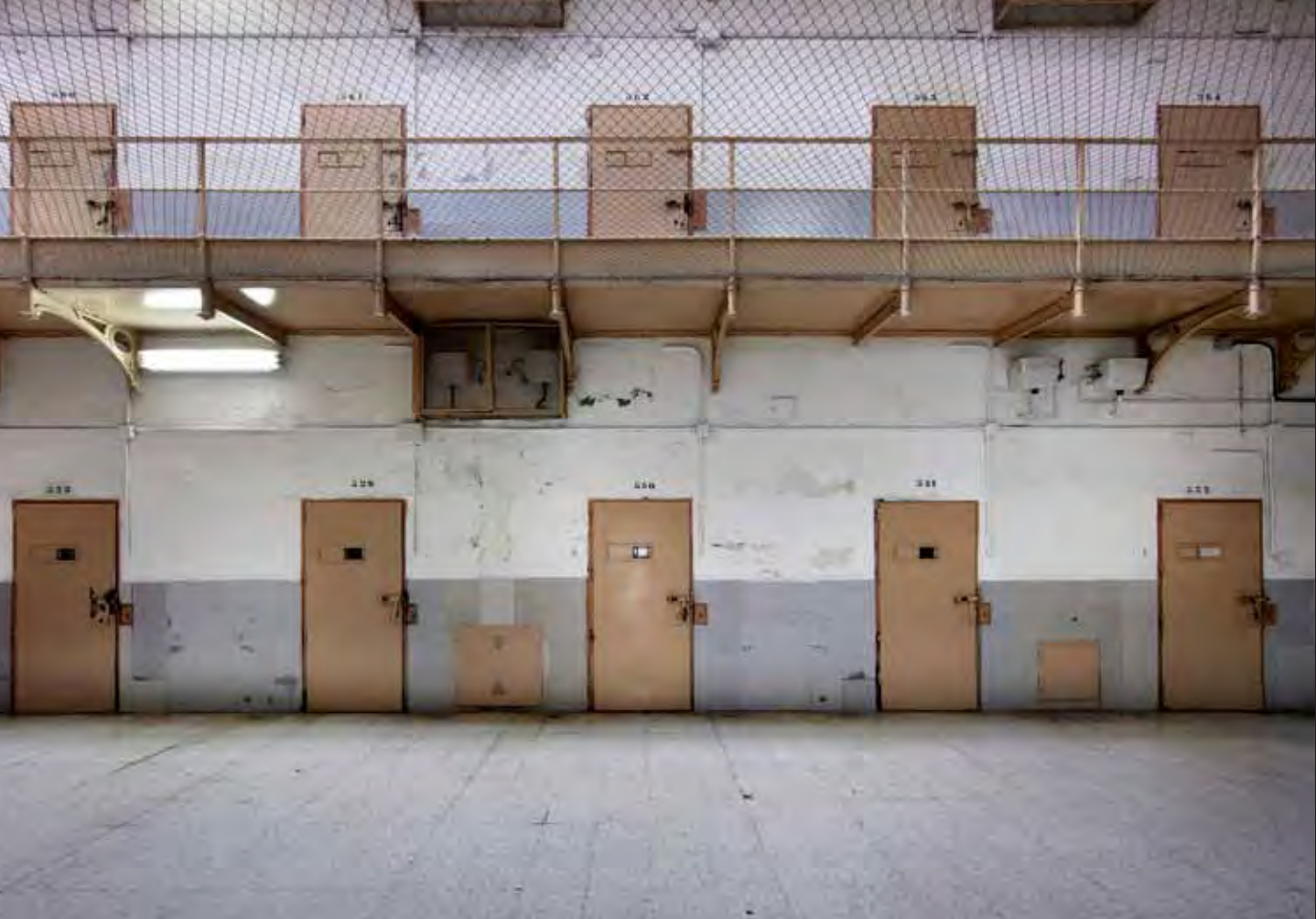
Filera de portes de les cel·les de la sisena galeria.
