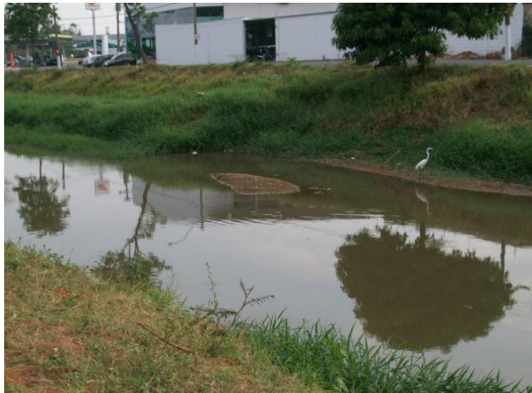
Figura 47 - Vista de um Trecho Assoreado no Ribeirão dos Toledos.
