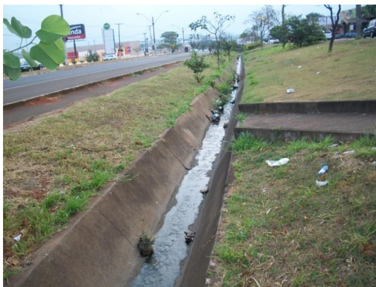
Figura 42 - Vista Geral do Sistema de Drenagem Superficial na Avenida Santa Bárbara.
