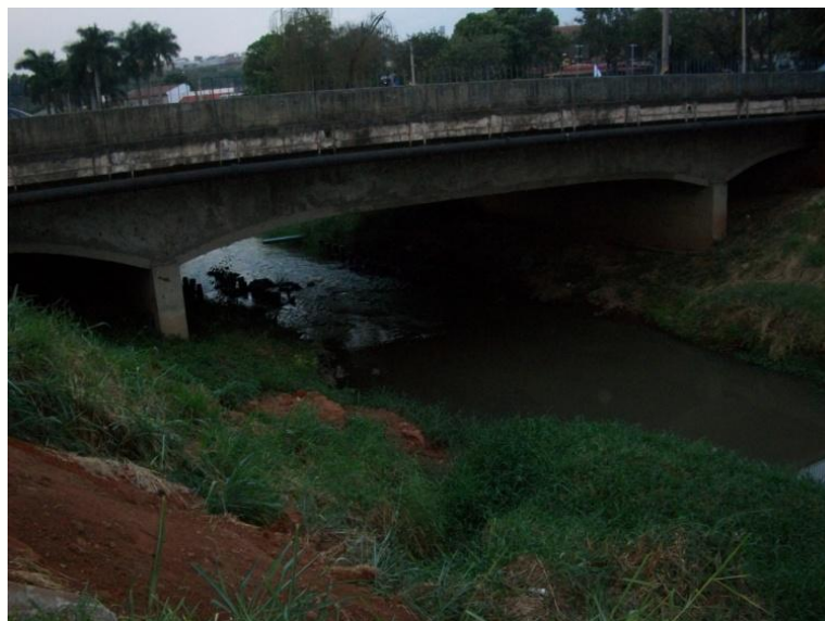
Figura 46 - Vista de Talude que Sofreu Erosão, Avançado o Leito do Ribeirão dos Toledos.
