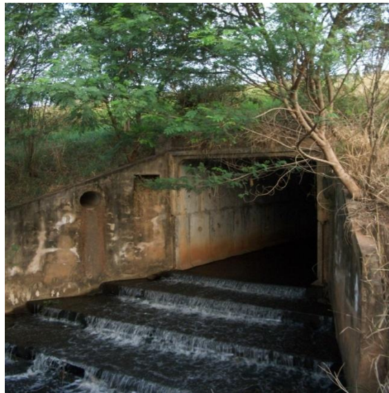
Figura 31 - Estrutura de Passagem Ponte Funda.
