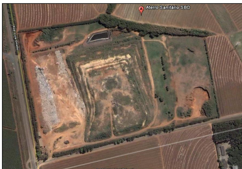
Figura 49 - Aterro Sanitário Municipal (Local armazenado dos resíduos de limpeza).
