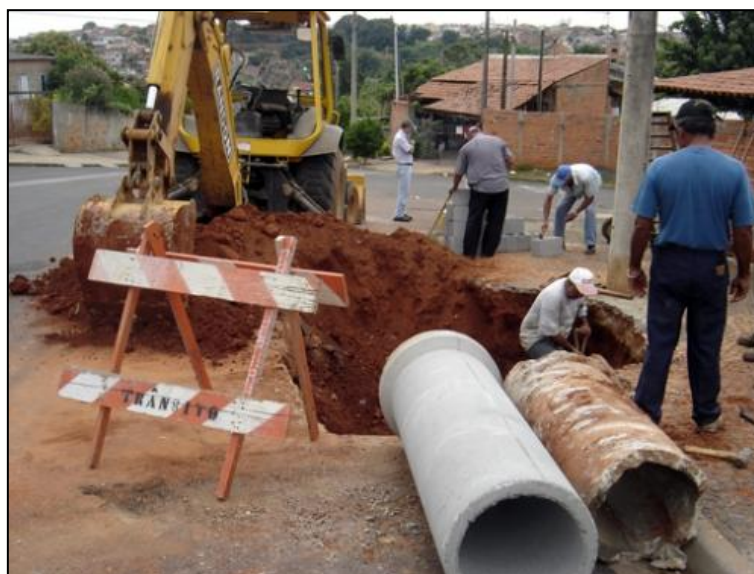
Figura 19 – Substituição de Tubulação de Drenagem e Reforma de Boca de Lobo de Guia no Bairro Zabani.
