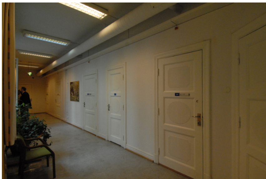
Korridor mot lysgård 2. etg. Foto: Leif Anker, Forsvarsbygg.
