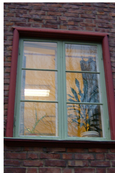
Vindu. Foto: Leif Maliks, Forsvarsbygg.
