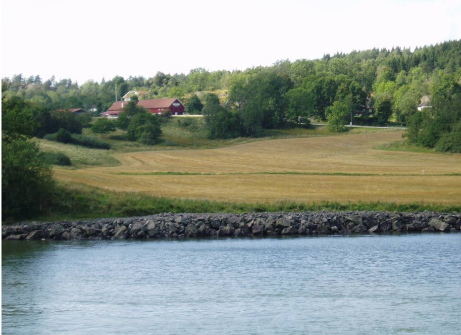
Figur 7-4 Erosionsskydd vid In- tagan (söder om Troll- hättan). Foto: SGI.
