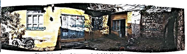
Güney (ön) cephe ve doğu yan cephesindeki eklentinin görüntüsü
