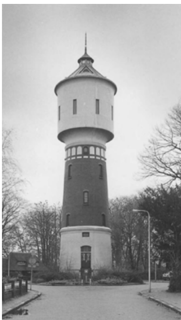
In 1914 gebouwd is de watertoren van Coevorden
