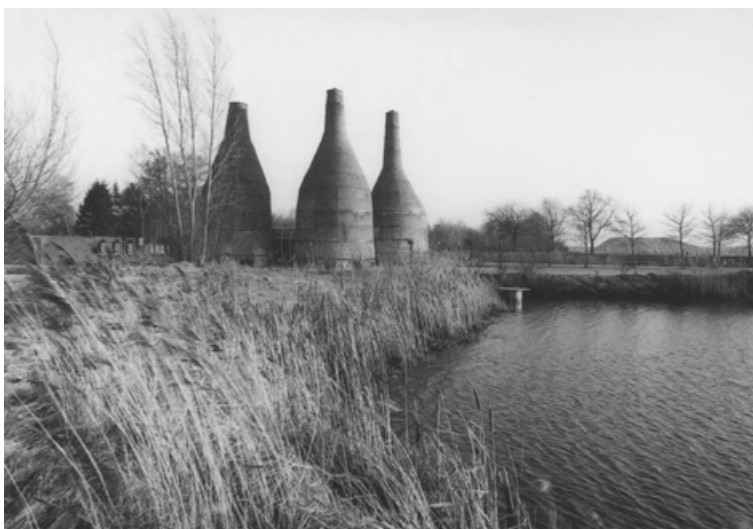
Van de langs de Drentsche Hoofdvaart gestichte kalkbranderijen resteert het uit 1875 daterende kalkovencomplex bij Meppel
