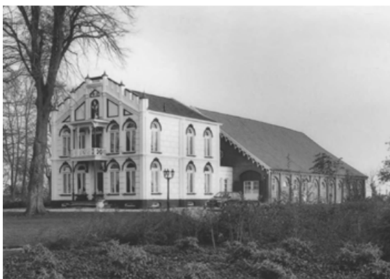
De herenboerderij Villa Flora te Nieuw-Buinen werd in 1877-'79 gebouwd in opdracht van de glasfabrikant J.C.A. Thöne
