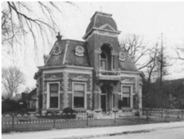
Het villa-achtige voorhuis van de boerderij Dijkhuizen 13-15 te Ruinerwold (1892-'93) vertoont een staalkaart aan eclectische vormen
