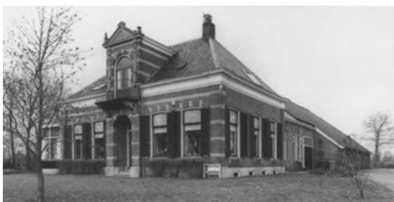
Het dak van het rond 1900 gebouwde voorhuis van de boerderij Haakswold 12-14 te Ruinerwold is gedekt met de op leien gelijkende Lucas IJsbrandspannen
