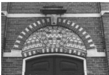
Opmerkelijk mozaïekwerk in bricorna-stenen boven de ingang van de Geref. kerk te Nieuw-Weerdinge uit 1907
