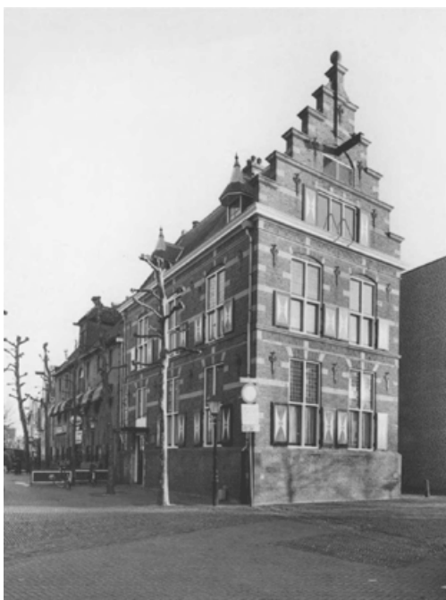
Meppel, Trafohuis met bovenwoning
