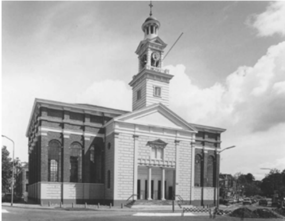
De (Herv.) Jozefkerk te Assen (1848) is naar plannen van C.J. Spaan rijk uitgevoerd in neoclassicistische stijl (1986)
