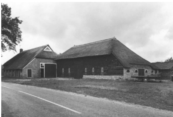
De uit circa 1850 daterende hallenhuysboerderij Pieperij 7 in het gehucht Pieperij heeft een aangebouwde schuur en een voor Zuidwest-Drenthe karakteristieke baander met loopdeur (1980)
