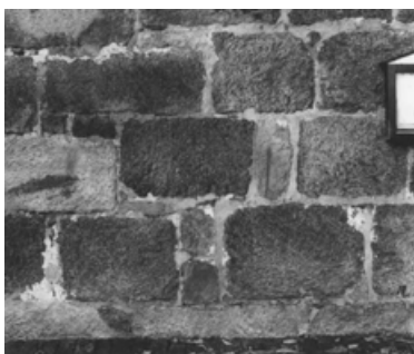
Het koor van de Herv. kerk te Odoorn is opgebouwd met gekantrechte granieten zwerfkeien. Van de bij het kloven van de stenen aangebrachte boorgaten zijn bij de voegen nog sporen zichtbaar
