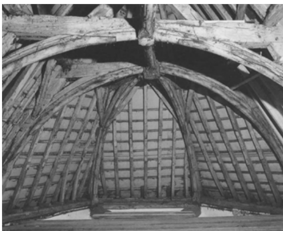
Kapconstructie van het koor van de Herv. kerk te Nijeveen in de situatie net voor de restauratie in 1976, waarbij het houten tongewelf is gereconstrueerd tegen de als gewelfribben dienende gebogen en geprofileerde jukbenen en korbelen (1976)
