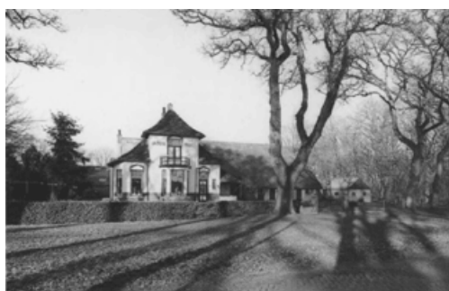
Westeinde, Woonhuis Olden Hut
