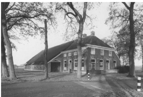
Karakteristiek bij de uit 1912 daterende boerderij annex café Hoofdweg 118 te Oudemolen (bij Tynaarlo) is het langgerekte tweelaags voorhuis
