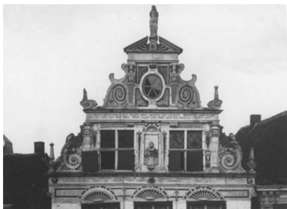
De fraaie geveltop uit 1631 van het huis Friesestraat 9 te Coevorden vertoont een grote rijkdom aan laat-maniëristische vormen (1901)
