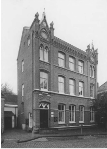
Het opmerkelijke post- en telegraafkantoor van Assen (1874) is uitgevoerd in romantisch getinte neogotische vormen
