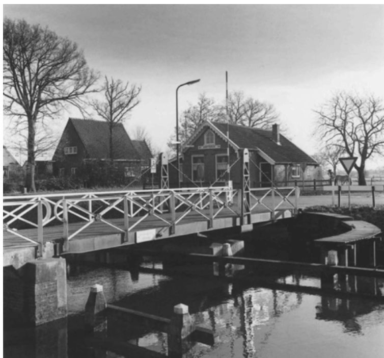
Zwinderen, Brugwachterswoning Driftbrug
