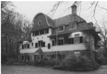
Huize De Lariks te Assen is in 1914-'15 opgetrokken in 'Um 1800'-vormen. Karakteristiek zijn het geknikte schilddak en de grote klokvormig afgesloten dakerker
