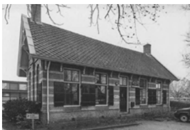
Bepalend voor het uiterlijk van het douanegebouw te Coevorden (1891-'92) is de dakbedekking met ruitvormige Helderse pannen
