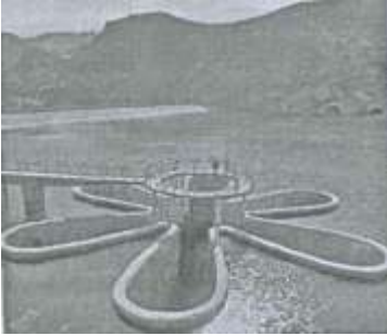
Bazar çay üzərində Şam SES-in görünüşü.
