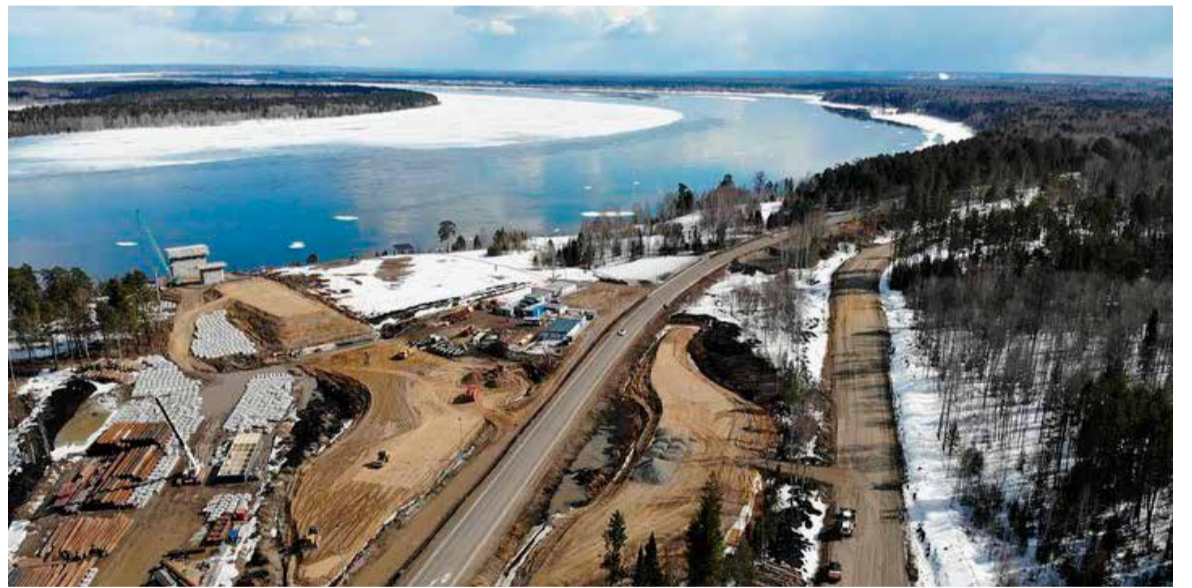
Начало строительства Высокогорского моста через Енисей.
