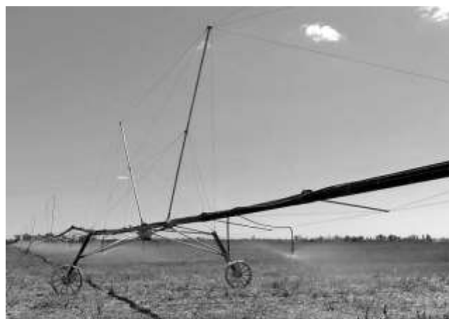
Рис. 3 Фотография пролетов длиной 45 метров с композитным трубопроводом
