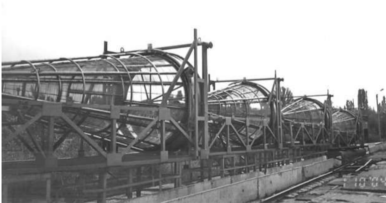
Рисунок 1 – Рыбозащитное устройство типа «Конусная сетка с рыбоотводом (КСР)»
