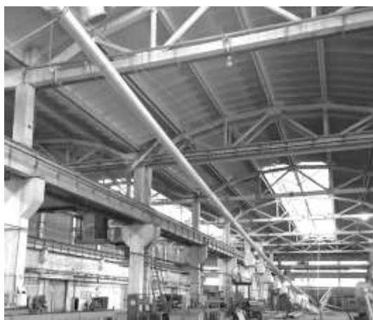
Рис. 2 Фотография пролета длиной 76 метров под испытательной нагрузкой
