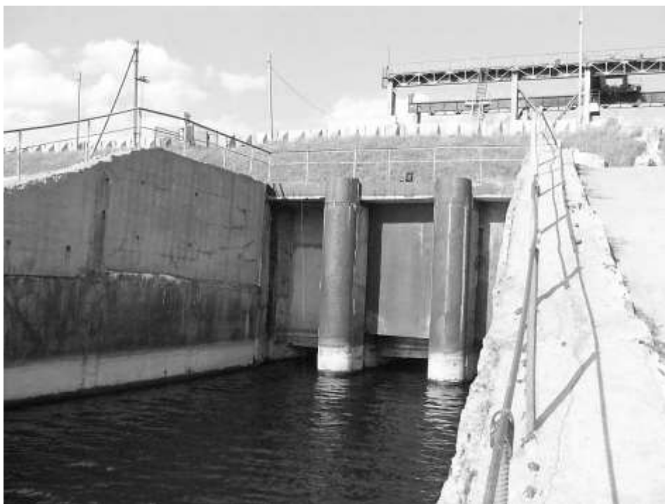
Рисунок 1 - Водосброс-водоотпуск (вид со стороны нижнего бьефа)
