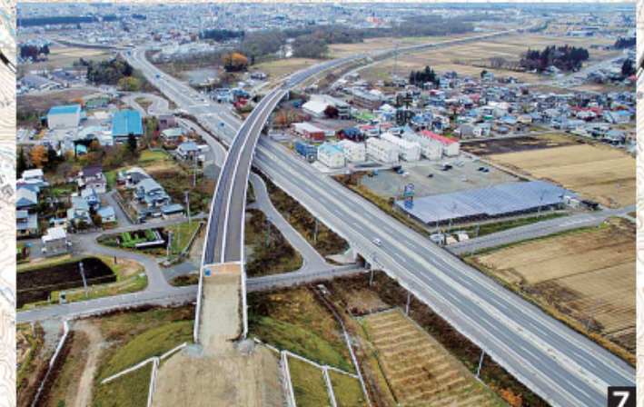
▲万世高架橋(仮称)
