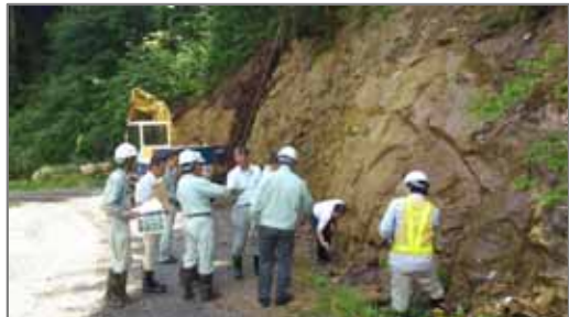
▼現地調査状況
