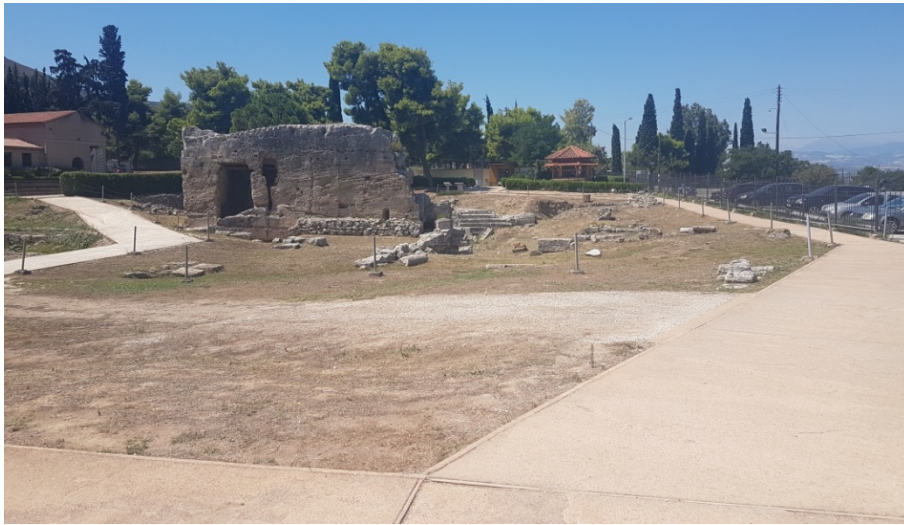
Εικόνα 46 Χώροι κίνησης από σταθεροποιημένο κεραμικό δάπεδο Πηγή: ό.π.
