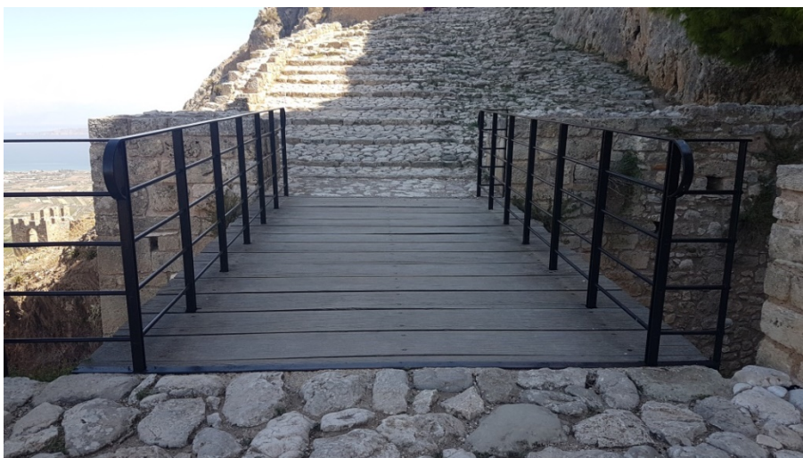
Εικόνα 63 Η μεταλλική γέφυρα πάνω από την τάφρο Πηγή: ό.π.
