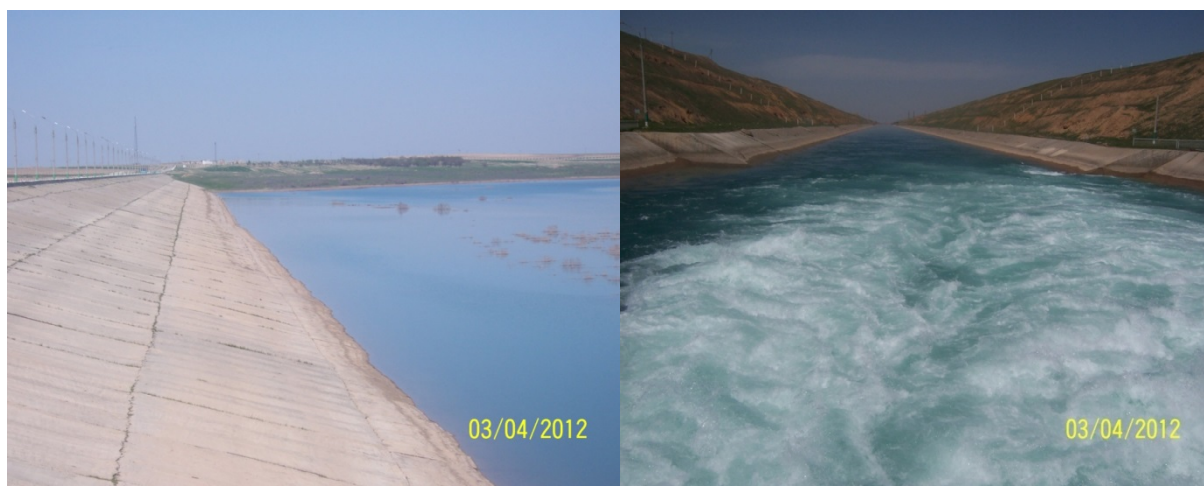
5.9 - rasm. Suv ombordan suv chiqish joyidagi kanal va to'g'on holati
