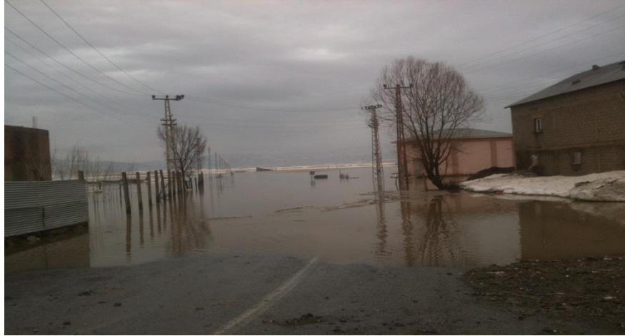
Foto: 2 Sungu beldesinde taşkında sular altında kalan karayolu.
