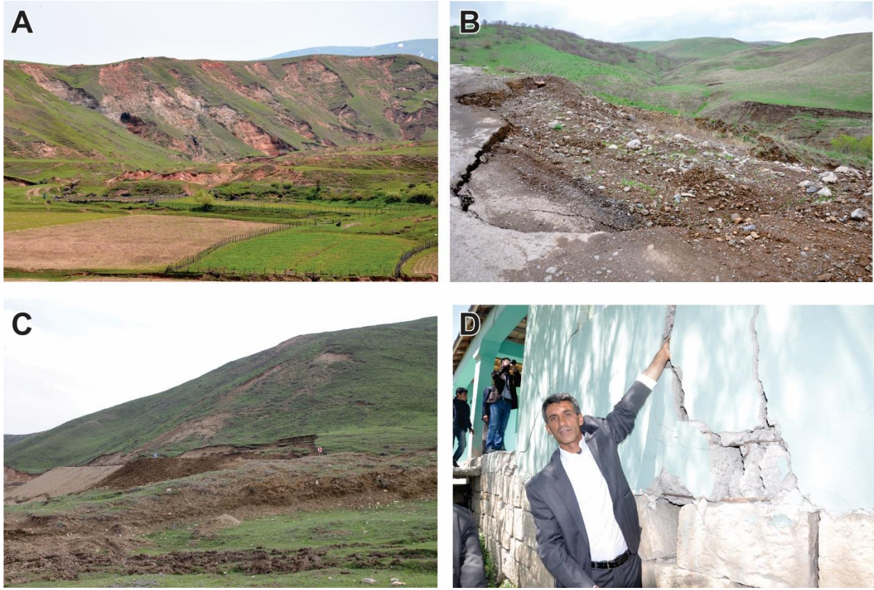
Şekil 8: İlkbahar döneminde (2014-2015) gelişen sığ ve aktif heyelanlara örnekler. (A) Kızılağaç beldesinde gelişmiş sığ kaymalar, (B) Varto yolu üzerinde gelişen heyelana bağlı yolda oluşan deformasyon, (C) Şahinler Köyü mevkiinde yolda gelişen sığ bir kayma, (D) Ağartı köyünde 2014 yılında gelişen heyelana bağlı olarak oluşan yapı hasarları.
