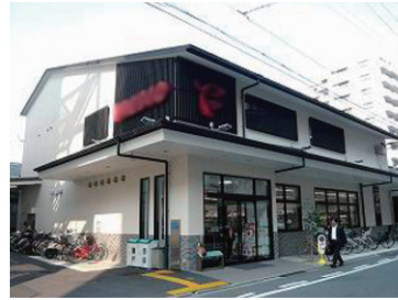
周辺の景観に配慮し、木材以外の素材を用いて格子を模した建築物。
