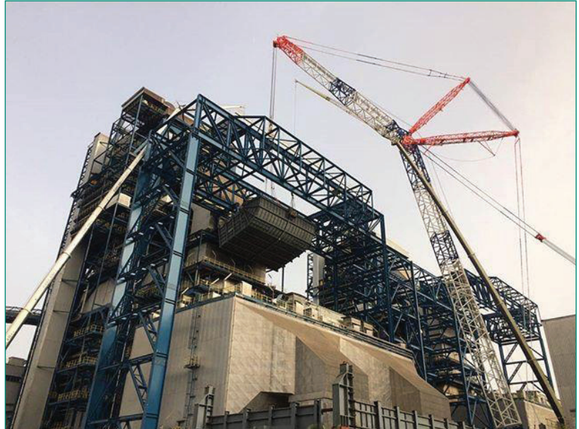
Fotoğraf: İSKEN-SU GÖZÜ Termik Santrali SCR - DeNO x Reaktörü Montaj Çalışmalarından Bir Görüntü [33]
