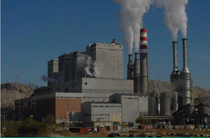
Fotoğraf: Çayırhan Termik Santrali ve BGKA Tesisleri (4 ünite, ıslak bacalı) Kaynak [32]
