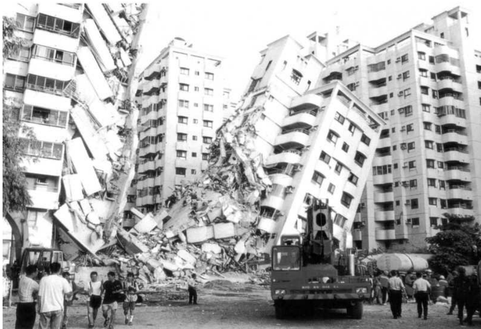
図 1-11 地震で倒壊した台中市大里のビル
