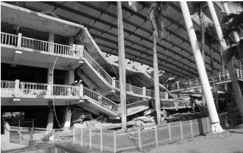
図2 九二一地震教育園区内の地震で崩壊した中学校の校舎 (2013年2月 筆者撮影)
