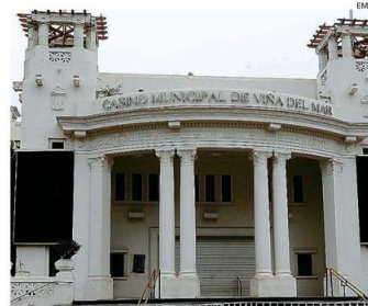
SE EXTINGUEN LOS PLAZOS PARA QUE ENJOY CUMPLA CON LAS OBRAS.
