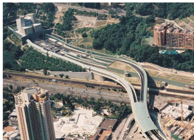
沙田嶺隧道 Sha Tin Heights Tunnel
