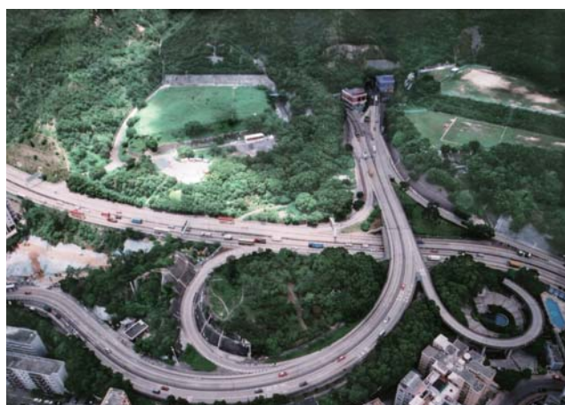
獅子山隧道 Lion Rock Tunnel
