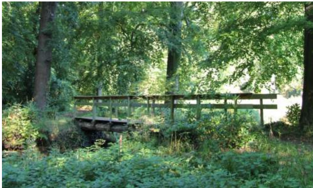
B2 Brug in het Vijverpark
