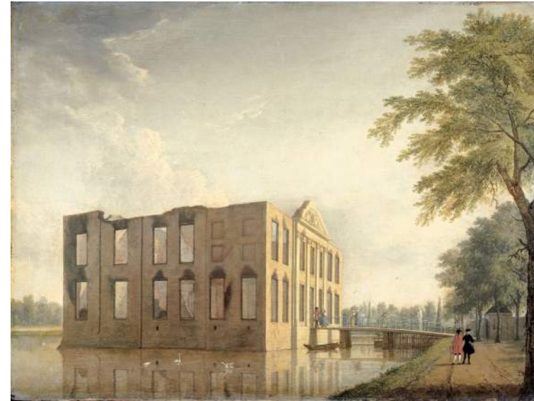
De zuid- en oostgevel van huis Berkenrode na de brand van 4-5 mei 1747. Schilderij door Jan ten Compe. Collectie Rijksmuseum Amsterdam.
