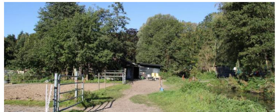
Zicht op de voormalige koeienstal met diverse soorten hekwerken
