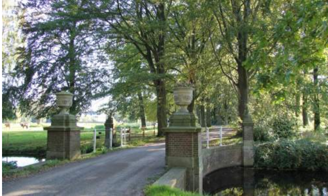
B1 Toegangsbrug naar het voorplein
