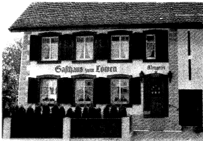
Abb. 4: Einfühlsame Renovation im Sinne des traditionellen Baustils
