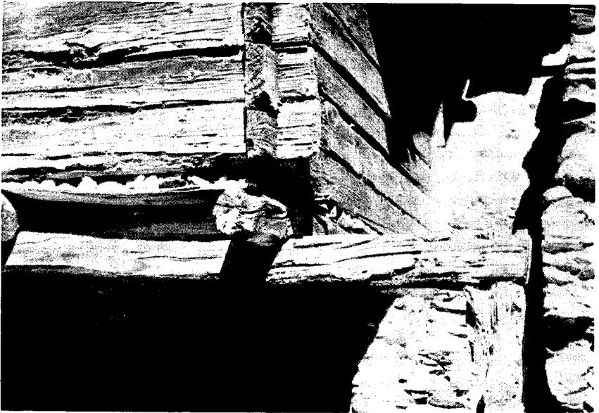
Fot. 2: il materiale di costruzione del salotto è il legno; le travi sono incrociate agli angoli, a cruséra
