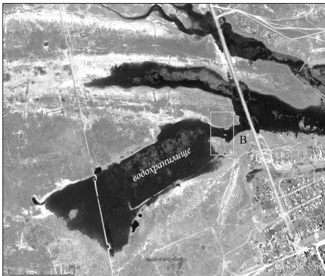
Рис. 8. Плотина и водохранилище на Солодовском ерике. А – на плане А.В. Терещенко (1843 г); В – на спутниковым снимке Google.
