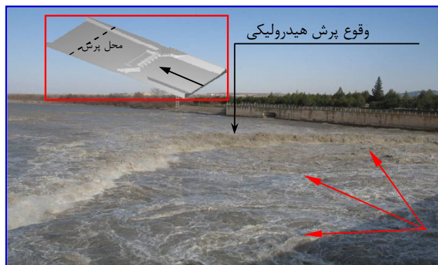
شکل 16 الگوی سه بعدی جریان در حالت تخریب شده (DMG) و عکس تهیه شده از شرایط موجود
