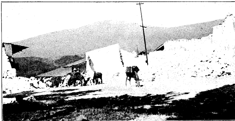
Fotografía número 1.—Casas destruidas en los costados de la Plaza de Teocelo, Ver. (Parte alta de la ciudad.)
