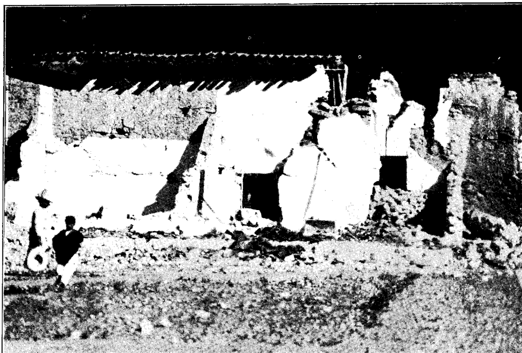
Fotografía número 1.—Exterior de la iglesia de Patlanalá, Pue. Destruída.
