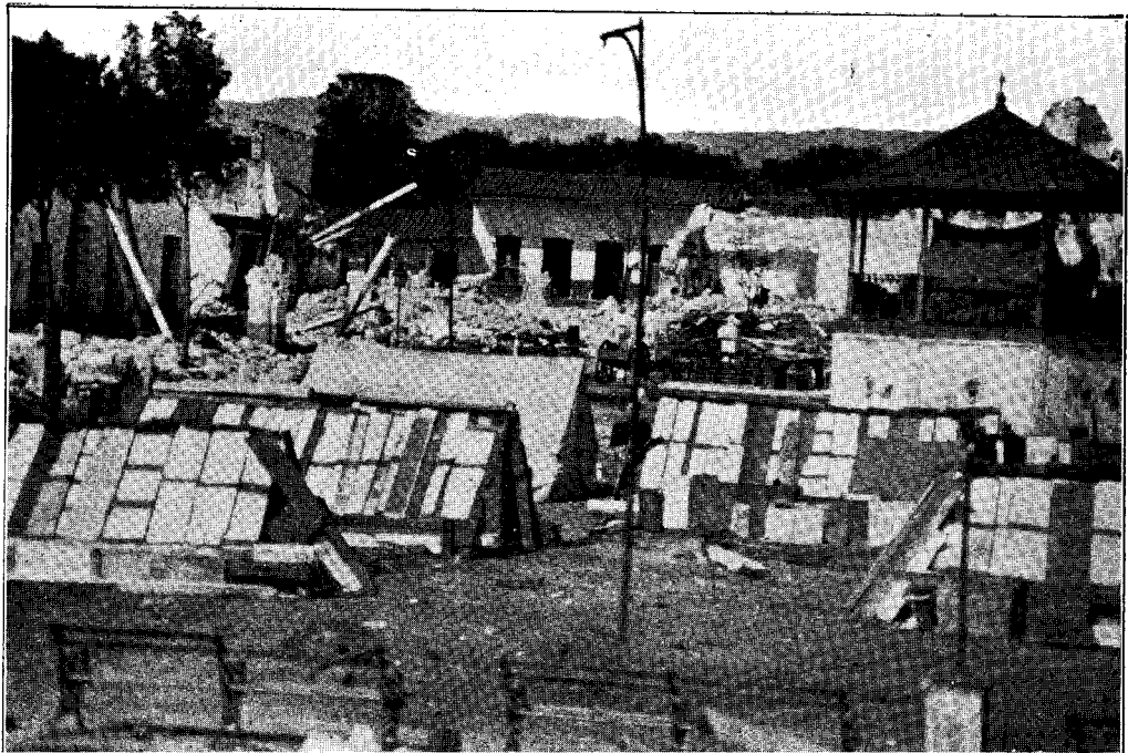
Fotografía número 2.—Plaza, kiosco y barracas construídas después del terremoto, en Cosautlán, Ver., para abrigo de los habitantes.
