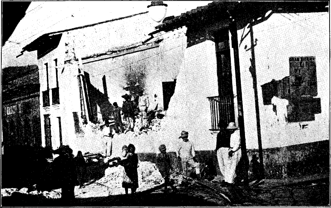
Fotografía número 1.—Casa destruída en la 4. a de Allende, Jalapa, Ver.
