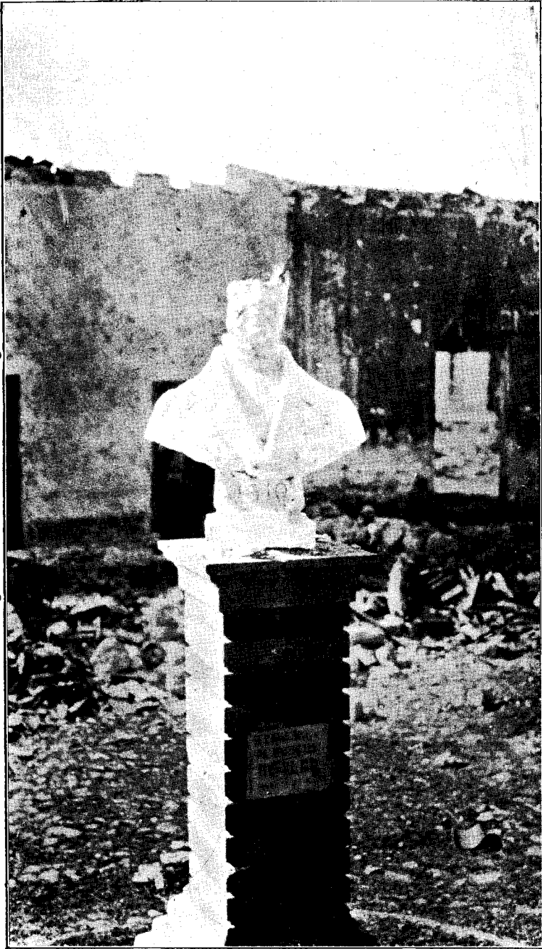
Fotografía número 1.—Busto de Hidalgo, movido sobre su pedestal. Plaza de Teocelo, Ver. (Rotación aparente.)
