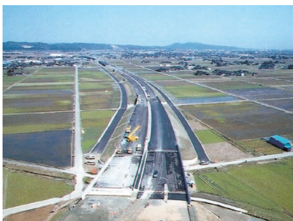
北へ向かって進む舗装工事（高岡市笹川地区）
