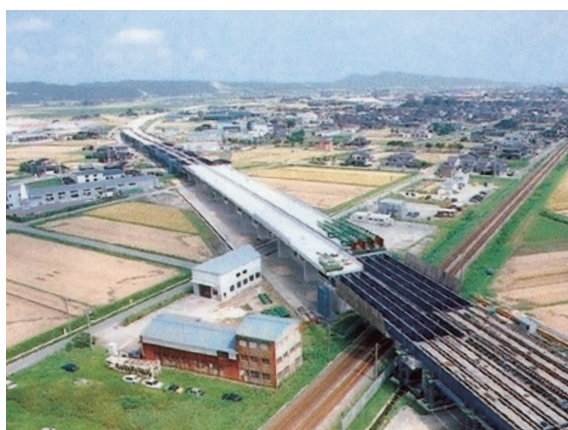
旧JR北陸本線を跨ぐ高架橋工事（高岡市宝来地区）
