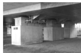
橋梁の耐震化（橋脚補強等）
