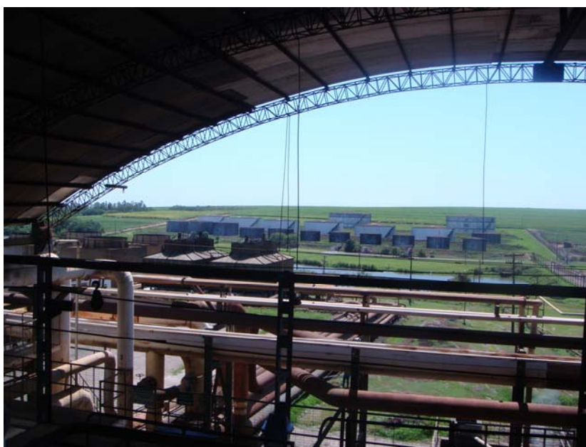
Figura 4.7 – Visão panorâmica da estrutura da usina Catanduva Fonte: Estudo de caso.
