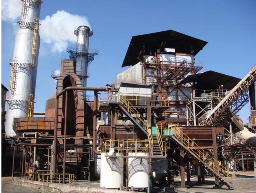
Figura 4.2 – Estrutura da usina Santa Cândida Fonte: Estudo de caso.
