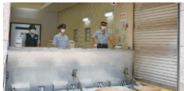
▲出入口止水板
