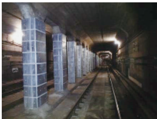
写真5 開削トンネル中柱の補強
