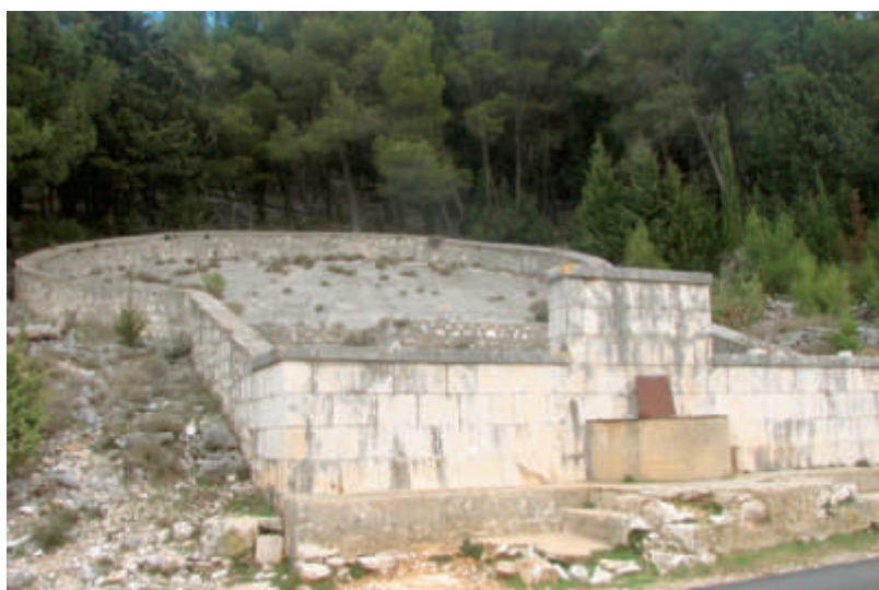
Ilustracija 1 Cisterna s nakapnom plohom u naselju Visočani [1]
