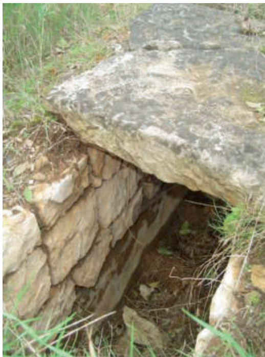
Ilustracija 3 Pogled na kanal starog vodovoda [7]
