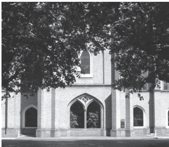
Deel van de manege later Willemskerk nu kantoorgebouw
