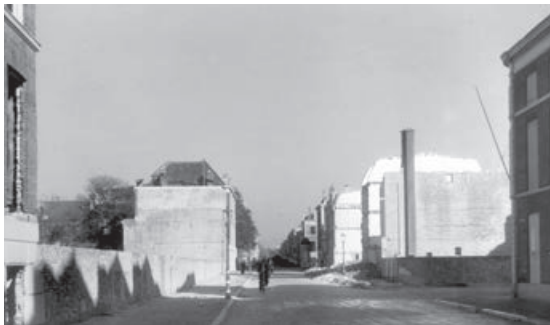
Het puin in de Riouwstraat na de V2 inslag is grotendeels opgeruimd (HGA)
