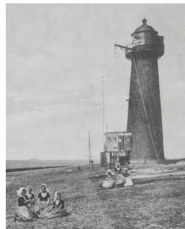
De vuurtoren in de jaren '10, met de in 1905 gebouwde houten uitkijkpost.
