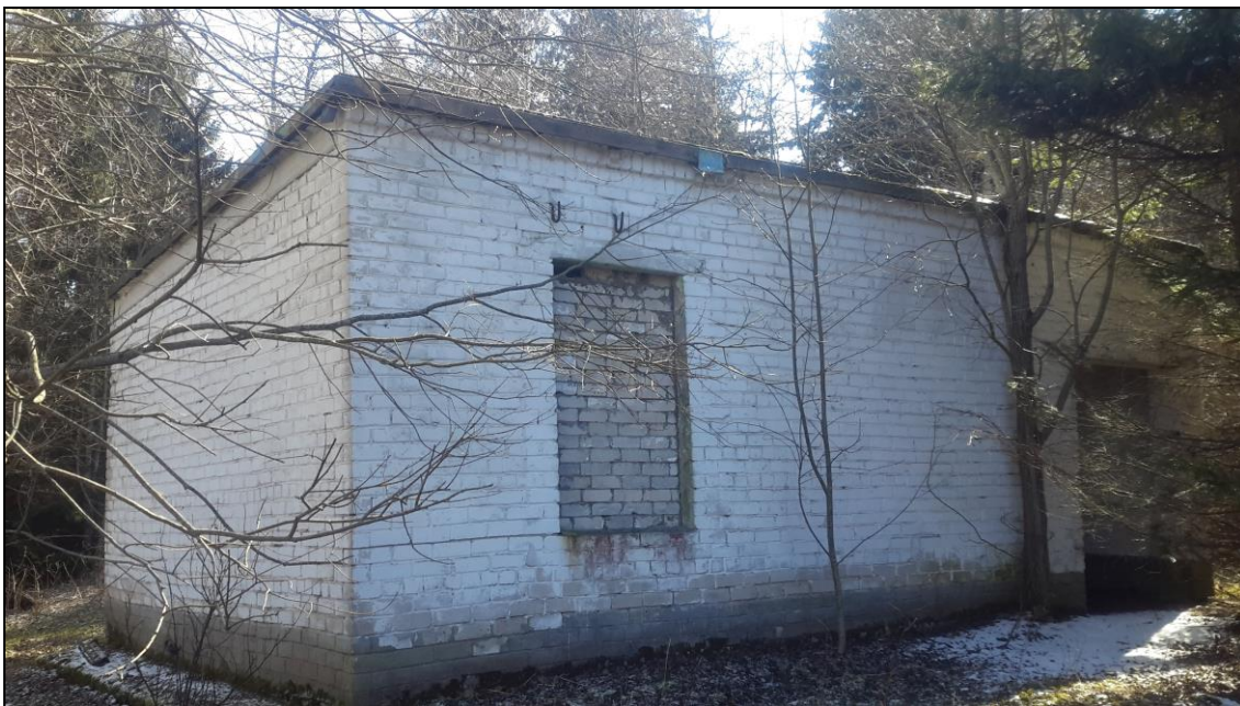
Foto 9. Andineeme (Tsitre) tehnilise vaatluse post. Operaatorihoone [3]. Foto Ain Tähiste 16.04.2017.
