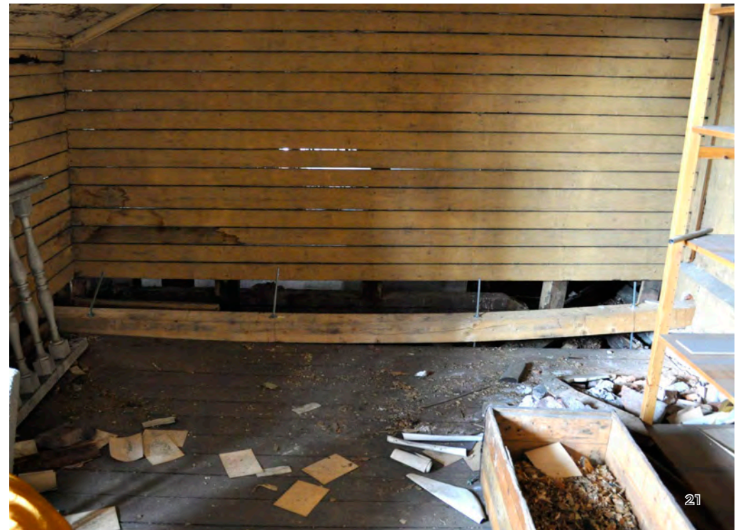
Kuva 4: Väliaikaisen tukirakenteen pää on kannatettu muurin tehdystä kolosta.
