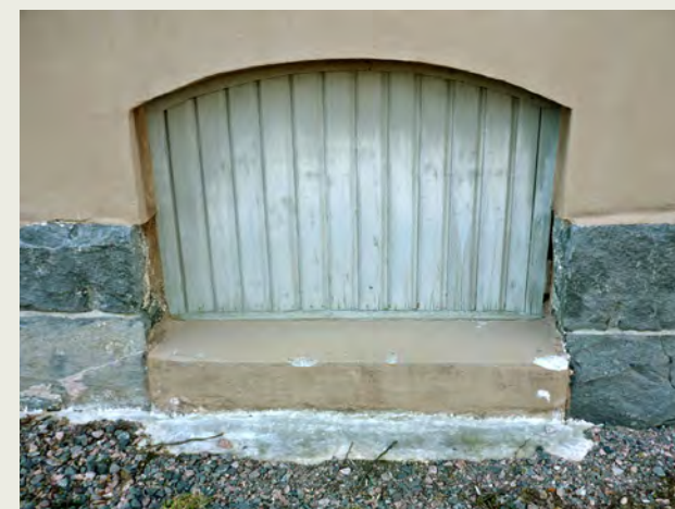
Kellarin ikkunat (yllä KI-6) ovat suurimmaksi osaksi olleet kolmiruutuisia. Nykyään kaikki kellarin ikkunat on ulkopuolelta joko paneloitu tai muurattu umpeen (alla KI-3).
