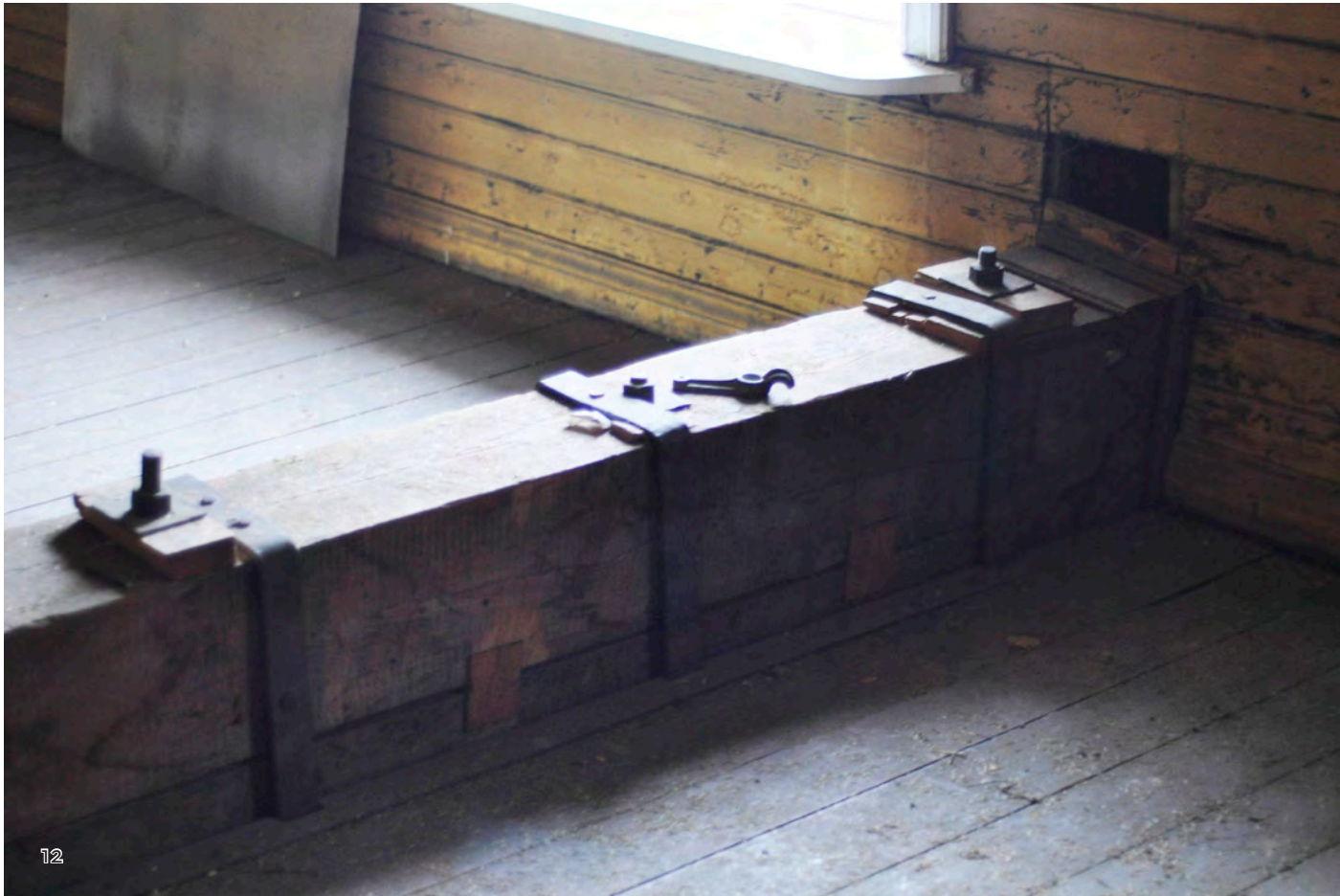
Kuva 2: Kiila-ansaan kohdalta katkaistut ulkoseinän sisäverhouspaneelit osoittavat, että kiila-ansas on lisätty tilaan jälkikäteen.
