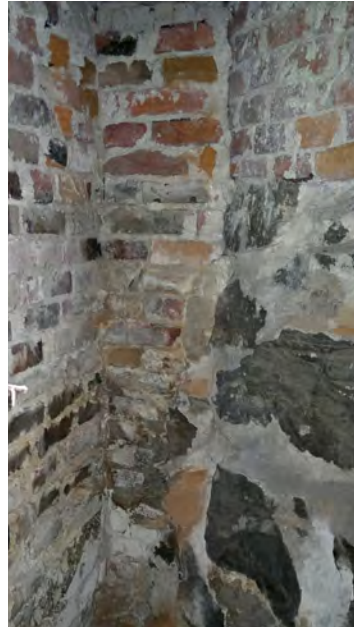
3. Kellaritilassa 010 ei-kantavat tiiliväliseinät yhtyvät tulisijojen perustuksiin.
