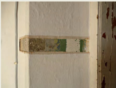
Huoneen 102 seinistä on otettu esiin värikerroksia.
