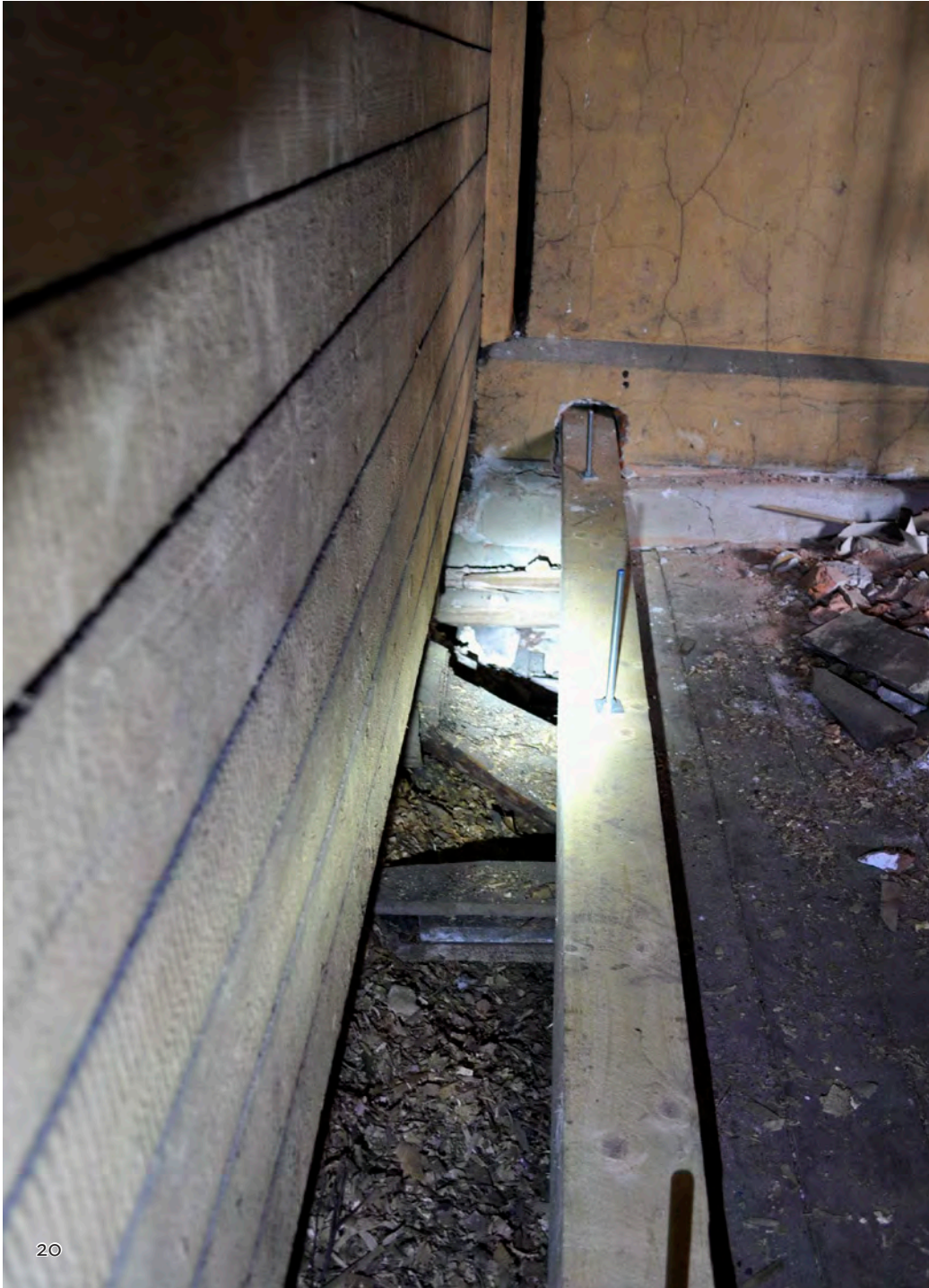
Kuva 2: Tukirakenne alapuolelta huoneesta 203. Palkin molemmin puolin näkyy tikutusta, joka on tullut esiin rappauksen irrottua romahtaneesta lattiasta.
