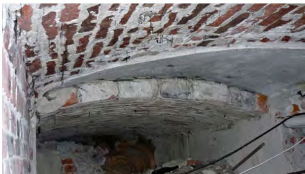
Tilassa 013 on kaksi erilaista tynnyriholvia (vasemmalla) sekä porraslankkujen alapinta (oikealla). Pitkittäisistä tiilistä muurattu holvi lienee Nummelinin aikaista; se on alimman porrasjuoksun yläpäässä olevan kivilattian alla. Holvin rapattu osa lienee Nummelinin tai Stenbäckin aikaisen käyttötilan kattoa. Poikittaisista tiilistä muurattu holvi lienee tehty kouluksi muutettaessa.
