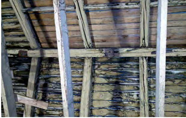
Kurkihirsi vinttihallissa 302. Kurkihirressä olevista jäljistä päätellen sen kannatusta on muutettu.
