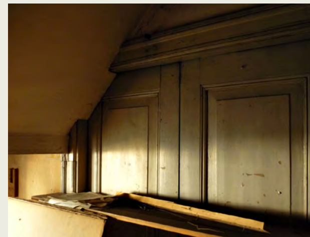
TO-6 on jäänyt osin uuden vintin portaan taakse. Toiselta puolelta ovi on levytetty piiloon.
