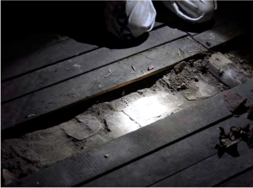
Kuva: Huone 308 ullakolla, avauskohta I. Tiilistä vapaasti ladottu palopermanto lattialautojen alla. Rakenteen tarkempi kuvaus Rakenne-osiossa.
