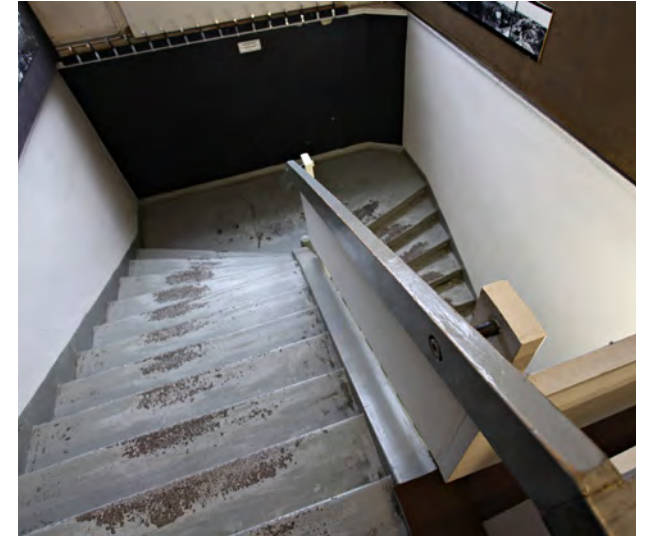
Pääportaan toinen juoksu tukeutuu tiilimuureihin. Kolmatta juoksuja kannattelee toiselta puolelta Nummelinin-aikainen tiilimuuri, ja toisen reunan tukena on betonipalkki. Portaan kaiteen on suunnitellut arkkitehti Heikki Koskelo 1950–1960-lukujen vaihteessa.
