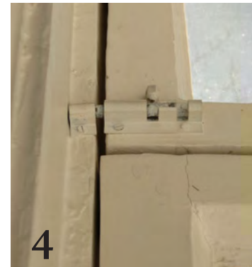
Ikkunoissa on käytetty neljää erilaista kiväärisalpaa.
