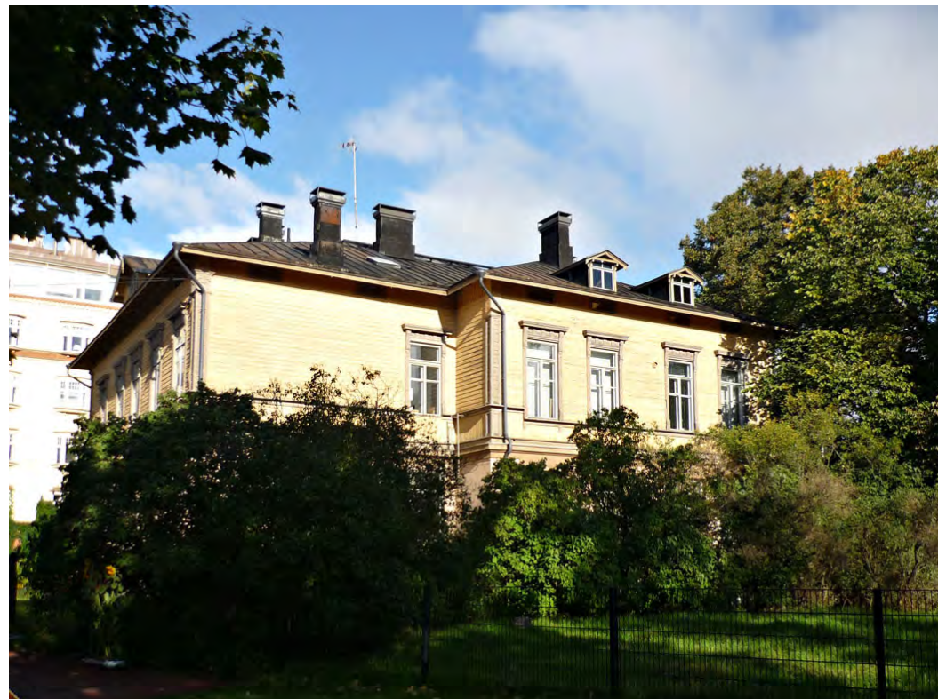
Puistokatu 4 puiston puolelta eli kaakkoissivulta.
