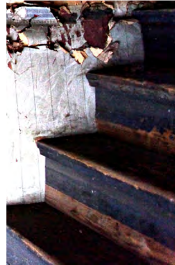
SvenskaSamskolanin aikaisessa vintinportaassa lienee käytetty Stenbäckin vuoden 1889 vintinportaan osia. Uusi vintinporras on sijoitettu edellistä pienempään tilaan, joten askelmia on jouduttu korottamaan.
