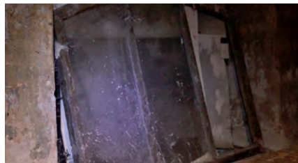
Tukittu ikkuna kellarissa.
