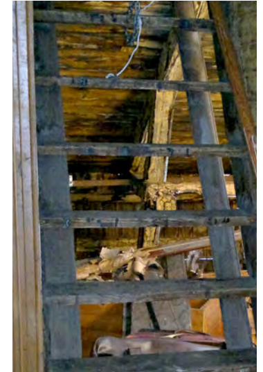
Vintiltä vesikatolle johtava tikasporras saattaa olla vuodelta 1889. Portaan alapinta on ollut paneloitu; paneeleita on kasassa portaan alla. Panelointi saattaa olla tehty samaan aikaan vintin kesähuoneiden kanssa vuonna 1904.
