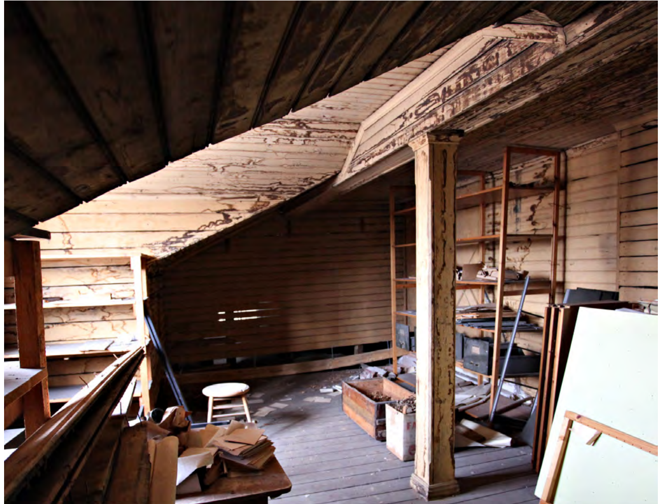
Vinttihuone 313. Kesähuoneen rakentamisen yhteydessä on vesikaton välipalkki ja kantavat pilarit paneeloitu. Pilareista on samalla poistettu vitaposket. Huoneen perällä on yläpohjaa ja jossain määrin myös vesikattoa kannatteleva väliaikainen ansas vuodelta 2009.
