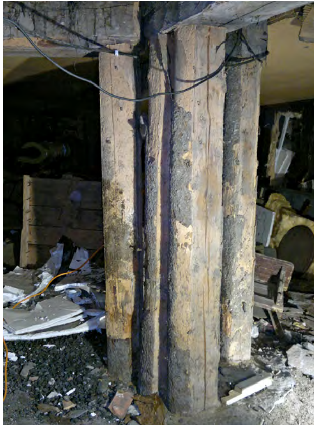
3. Puisia pilareita ja palkkeja kannattelemassa alapohjaa tilassa 014.
