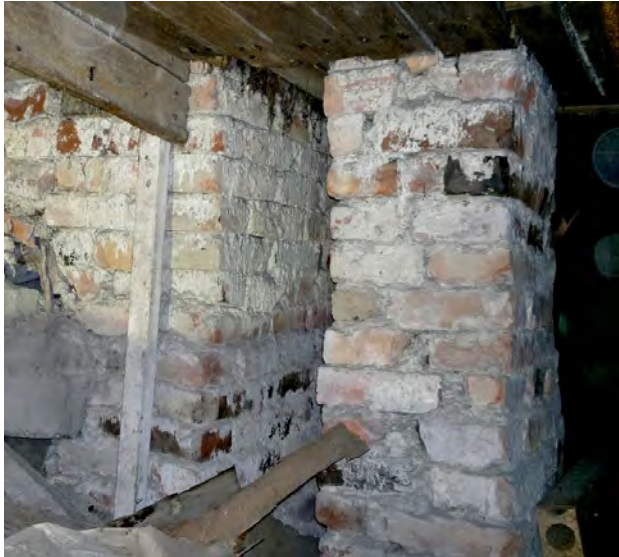
3. Tiilestä muurattu tulisijan perustuspilari kellaritilassa 017.
