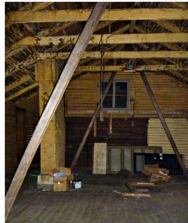
Vinttihallin 302 takaseinällä näkyy alakerrasta purettua rintapaneelointia. Väliseinässä on jäljellä sisäikkuna, jonka kautta suuren lapeikkunan valoa johdettiin viereisiin tiloihin. Museovirasto / Netta Böök 2010.
