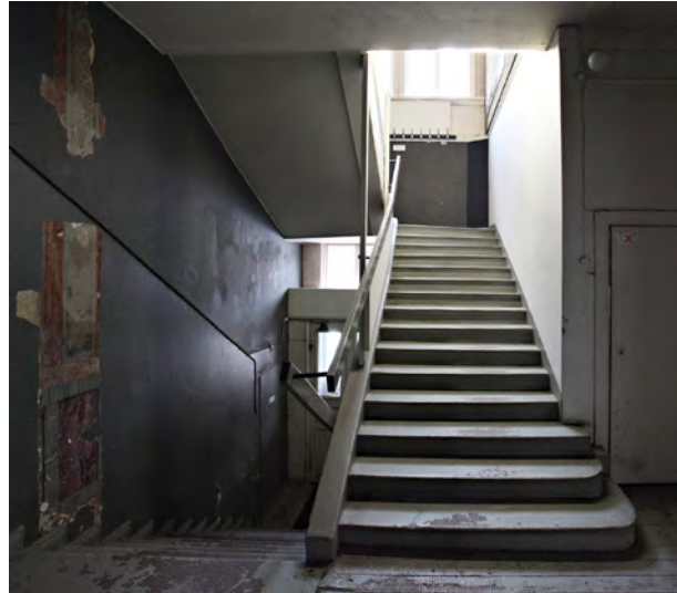
Pääporras alakerrasta kuvattuna. Vasemmalla oleva alin juoksu on luultavasti alkuperäinen Nummelinin huvilan juoksu, kaksi muuta juoksuja ovat vuodelta 1916. Uudemmissa juoksussa on ilmeisesti kierrätetty vuoden 1889 portaiden betonisia askellankkuja.
