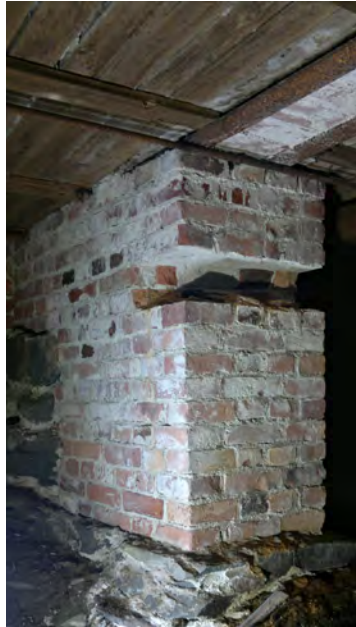
2. Kahden ja puolen kiven kantava tiilimuuri kellaritilassa 016. Muuri on rakennettu vuonna 1889, ja se tukee teräskiskopalkkia, joka kannattelee tilojen 103 ja 111 välistä seinää.
