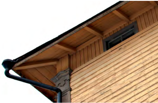
Yllä: Selkäpuiden päät kannattelevat räystästä. Vesikatto on varustettu pyöreillä syöksytorvilla ja suppiloilla.
