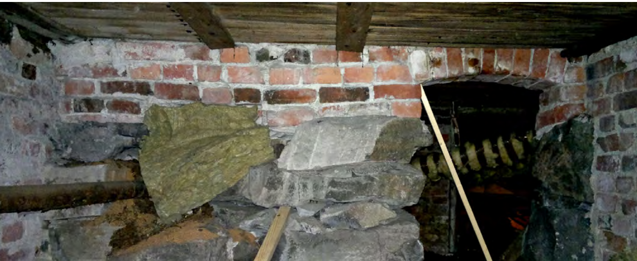
5. Oviaukon holvaus vuonna 1916 rakennetussa kantavassa tiiliseinässä komerotilassa 116.
