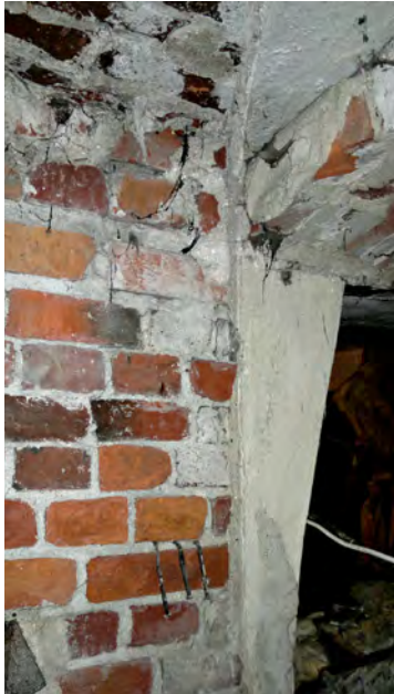
1. Vuoden 1881 seinärakenteen rappauksessa erottuu vuoden 1889 käyttökellarin raja kellaritilassa 013. Seinään on jäänyt puretun väliseinän tartuntanauvoja.
