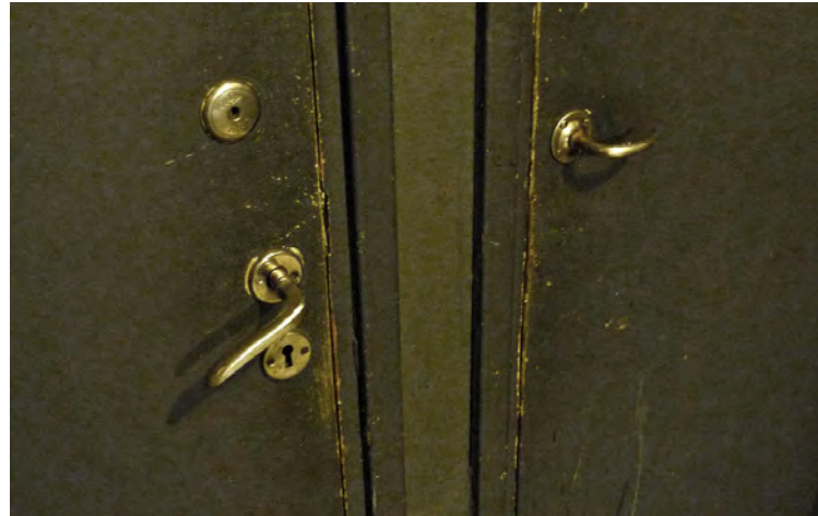
Funkispainike ja pieni pukinsarvipainike ovissa EO-17 (vasemmalla) ja EO-18 (oikealla).
