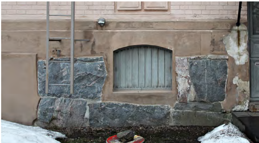
7. Rakennuksen kivijalkaa pääsisäänkäynnin vierestä. Koulun aikainen tyttöjen vessan ikkuna on laudoitettu umpeen. Poikien vessan ikkuna ja ovi vasemmalla on muurattu umpeen.
