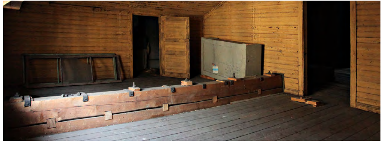
Lähikuva vinttihuoneen 309 kiila-ansaan yhdestä kiilasta ja ripustusteräksestä
