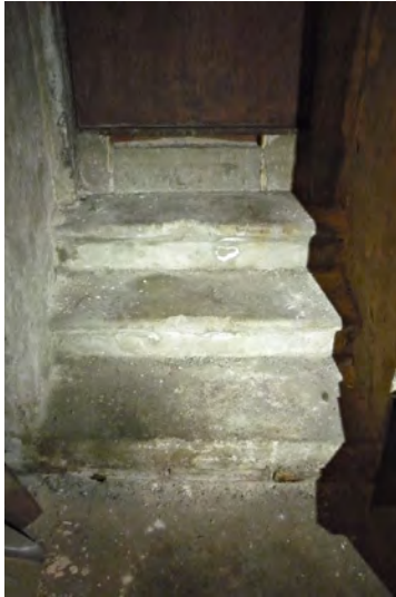
Pannuhuoneen porras. Porras lienee rakennettu kellariasunnon portaaksi vuonna 1889.
