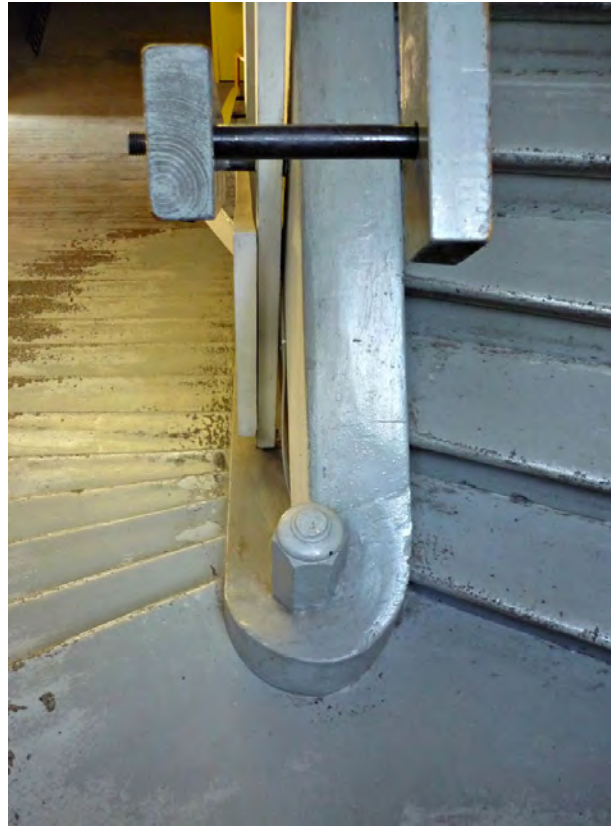
Betonilankuista kootun portaan nousu on 14,7 cm.
