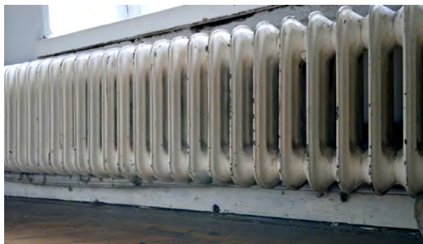
Högforsin Kesto radiaattori tilassa 102. Kesto-radiaattorit asennettiin rakennukseen mahdollisesti vuonna 1952. Högforsin tuotantoon malli tuli vuonna 1938.
