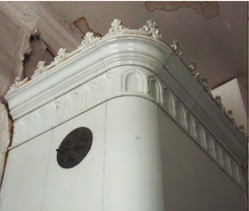
Huoneen 210 kakluunin poistoilmaventtiili.
