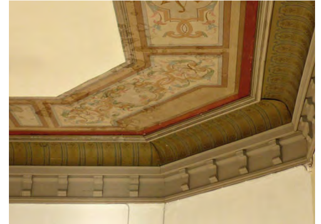
Huoneen 102 Stenbäckin-aikaisia kattolistoja ja koristemaalattua kattoa. Harmaa väri konsolivyöhykkeessä lienee uudempaa perua.
