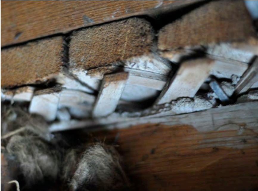
Kuva: Välipohjan alapuolisia rakenteita, avauskohta B.
