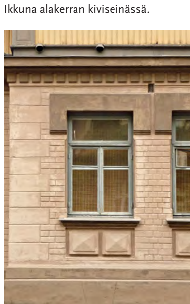
Ikkuna alakerran kiviseinässä.
