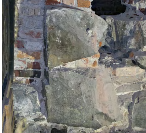
1. Yllä alkuperäisen etelänurkan kivijalan nurkkakivet kellaritilassa 103. Seinälinjaa siirrettiin puolisentoista metriä ulospäin vuonna 1889. Sokkelikivien yläpuolella olevaan tiilimuuraukseen piikatusta aukosta pääsee kurkistamaan puretun portaan alustaan.
