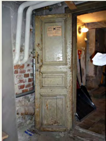
Kolmipeilinen kellarin ovi KO-6.
