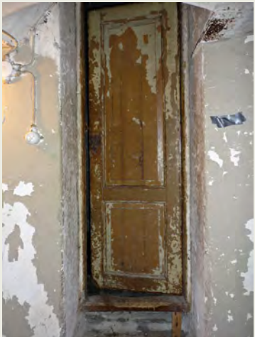
Kellariin johtava, kaksipeilinen ovi KO-4 kellarin puolelta.
