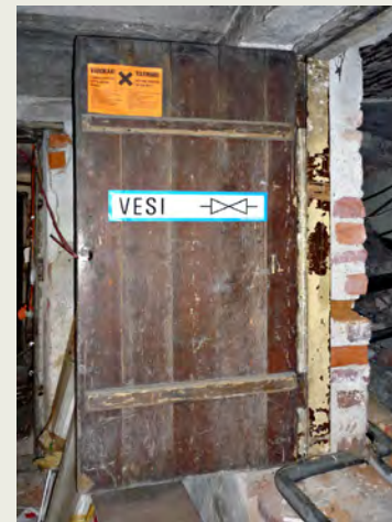
Lämpimistä kylmiin kellaritiloihin johtava lautaovi KO-7.
