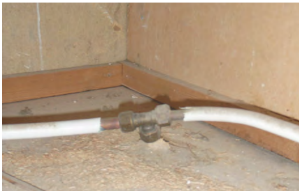
Vesijohdon läpivienti 1. kerroksen huoneesta 114 kellarikerrokseen.
