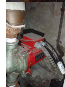
L3 Kolmeks AH-32X kiertovesipumppu.
