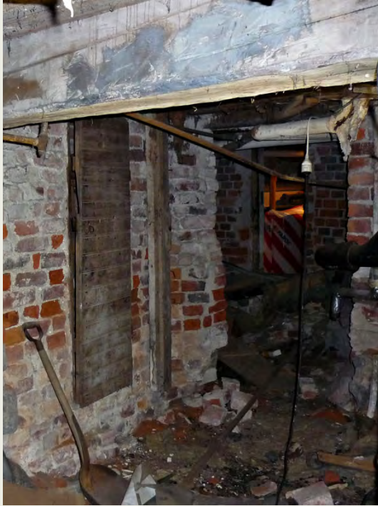
Kellarissa on paljon käyttämätöntä, kylmää tilaa. Näkymä tilasta 014 tilan 013 läpi käytävään 001.
