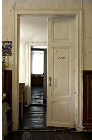
Kolmipeiliset pariovet, joissa keski-peili on korkea, TO-8.
