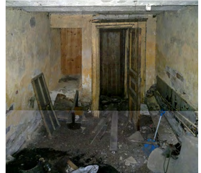
5. Vanha poikien vessa 002 kellarissa rakennuksen koillissivulla. Oviaukko ja ikkuna on muurattu umpeen ulkopuolelta. Seinää vasten nojallaan on vessan vanha ikkunapuite.
