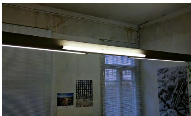
Loisteputki- ja pistorasia orsi huoneessa 210.
