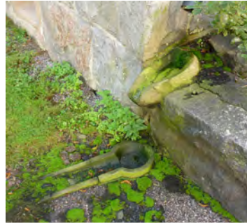
4. Vesikiviä rakennuksen pohjoisnurkan penkereessä.
