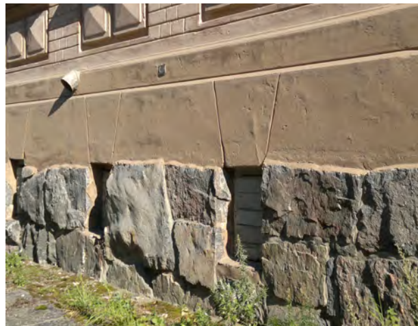
1. Yllä alkuperäisen etelänurkan kivijalan nurkkakivet kellaritilassa 103. Seinälinjaa siirrettiin puolisentoista metriä ulospäin vuonna 1889. Sokkelikivien yläpuolella olevaan tiilimuuraukseen piikatusta aukosta pääsee kurkistamaan puretun portaan alustaan.
