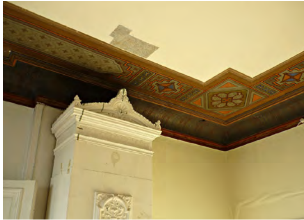
Huoneen 101 nurkka kaakeliuuneineen ja kattomaalauksineen. Kakluunista on otettu esiin useita värikerroksia.
