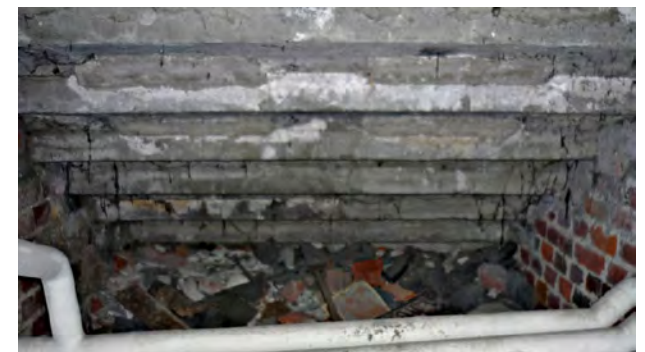
Tilassa 013 on kaksi erilaista tynnyriholvia (vasemmalla) sekä porraslankkujen alapinta (oikealla). Pitkittäisistä tiilistä muurattu holvi lienee Nummelinin aikaista; se on alimman porrasjuoksun yläpäässä olevan kivilattian alla. Holvin rapattu osa lienee Nummelinin tai Stenbäckin aikaisen käyttötilan kattoa. Poikittaisista tiilistä muurattu holvi lienee tehty kouluksi muutettaessa.
