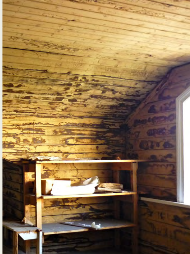
Vinttihuoneen 313 (yllä ja yllä oikealla) suuri kattolyhty on tehty ilmeisesti vuosien 1904 ja 1916 välillä sattuneen tulipalon jälkeen samassa yhteydessä, missä seiiniäkin on korjattu. Maalipinnoissa on lehtiruotomaista kuviointia.
