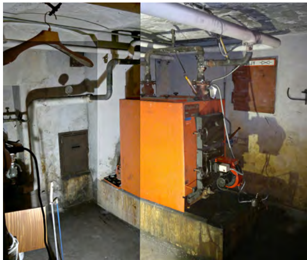
Pannuhuone 004. Punaisen teräsluukun takana on öljysäiliön tila 005. Tilat jakava väliseinä on vuodelta 1959. Tilassa oli asunto aina 1950-luvulle asti.
