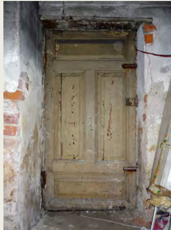
Nelipeilinen kellarin ovi KO-8.
