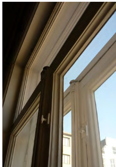
Miltei kaikki talon ikkunat on tehty ilman postipuita ja suurin osa myös ilman luusholtsia, eli ikkunoissa on niin kutsutut yhtyvät puitteet.
