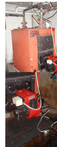
L1 Valurautainen Högfors 20 lämpökattila.
