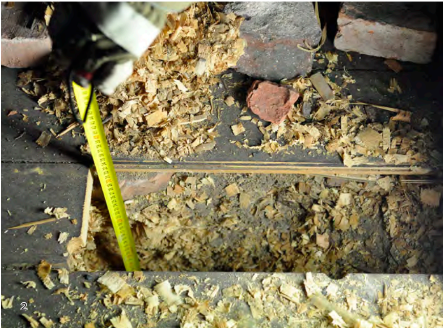
Kuva: Huone 309, Avauskohta A: Jälkikäteen ajateltuna avauskohta osoittautui kuitenkin liian pieneksi, koska sen kautta emme päässeet käsiksi välipohjan kantaviin rakenteisiin.
