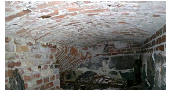
Stenbäckin vuoden 1889 eteläportaan porrashuoneen alapohjaa kannattelevat tynnyriholvit tilassa 018. Tilan takaosassa laskeutuu vasemmalle portaan alimman juoksun holvi.
