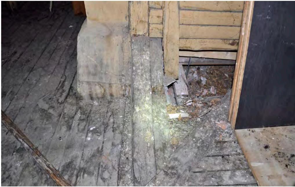
Kuva 3: Hormia kiertävän vekseli- vuoliaisen pää huoneessa 315.
