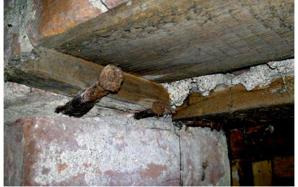
6. Holvin teluksen kiinnitys seinään oviaukossa tilojen 016 ja 008 välissä.
