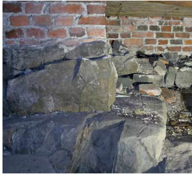
4. Savupiipun perustusta kellaritilassa 019.
