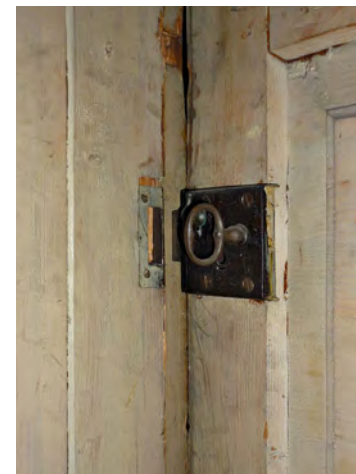
Avainvääntimellä varustettu kamarilukko vinttikamarin ovesta VO-13.
