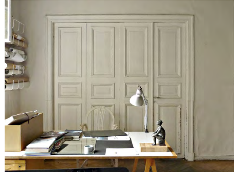
Huoneiden 207 ja 208 välinen paljeovi TO-7 on koottu kahdesta keskenään suunnilleen samanlaisesta pariovesta. Oviprofilit ovat kuitenkin keskenään hiukan erilaiset.
