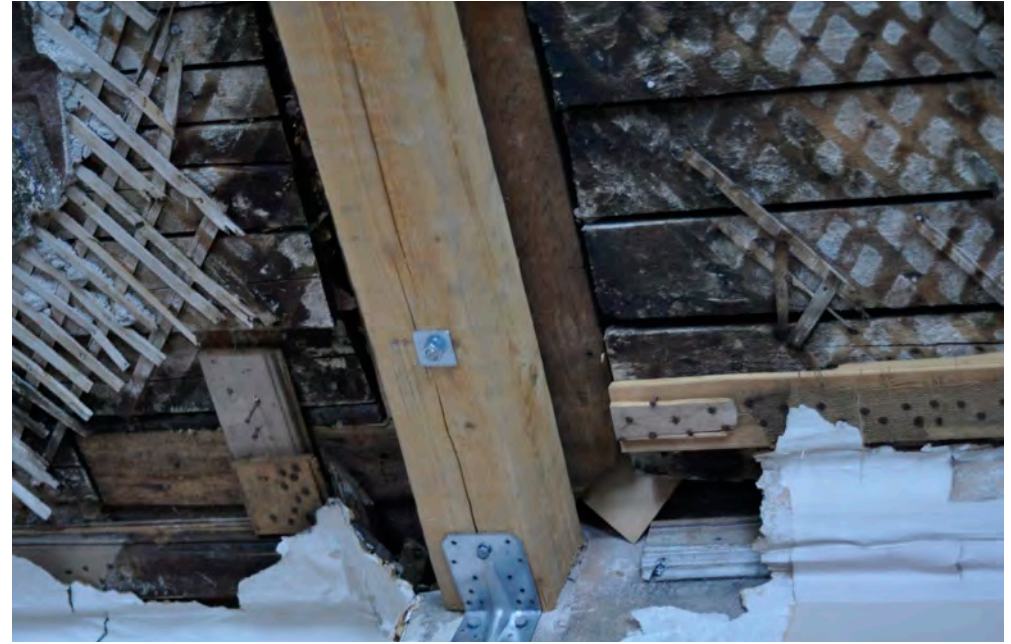
Kuva 2: Tukirakenne alapuolelta huoneesta 203. Palkin molemmin puolin näkyy tikutusta, joka on tullut esiin rappauksen irrottua romahtaneesta lattiasta.
