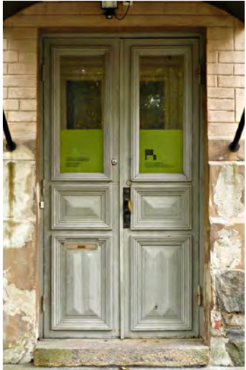
Pääoven KO-1 ovilehdet ovat kolmipeiliset siten, että yläpeileinä on lasit. Keskimmäiset peilit ovat matalat.
