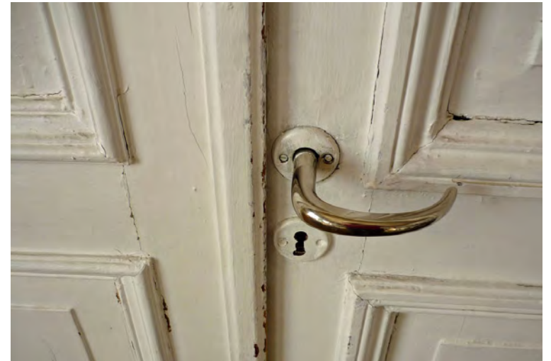
Huoneiden 207 ja 208 välinen paljeovi TO-7 on koottu kahdesta keskenään suunnilleen samanlaisesta pariovesta. Oviprofilit ovat kuitenkin keskenään hiukan erilaiset.
