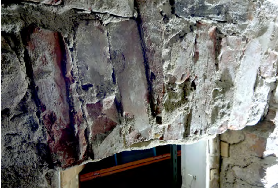
5. Oviaukon holvaus vuonna 1916 rakennetussa kantavassa tiiliseinässä komerotilassa 116.
