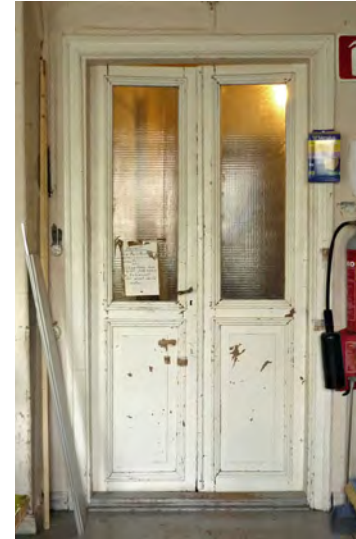
Kaksipeiliset pariovet, joissa yläpeileissä on rautalankalasis, EO-15.
