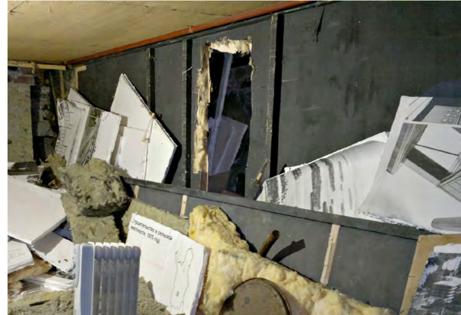
4. Museon aikana rakennettu kevytrakenteinen eristävä seinä Puistokadun puoleisen ulkoseinän edessä kellaritilassa 014.
