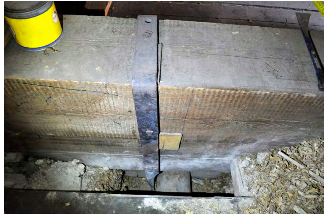
Kuva 3: Kiila-ansas pohjoispuolelta, kuvassa keskellä vuoliaista kannatteleva kiila-ansaaseen kiinnitetty tukirauta, avauskohta J.
