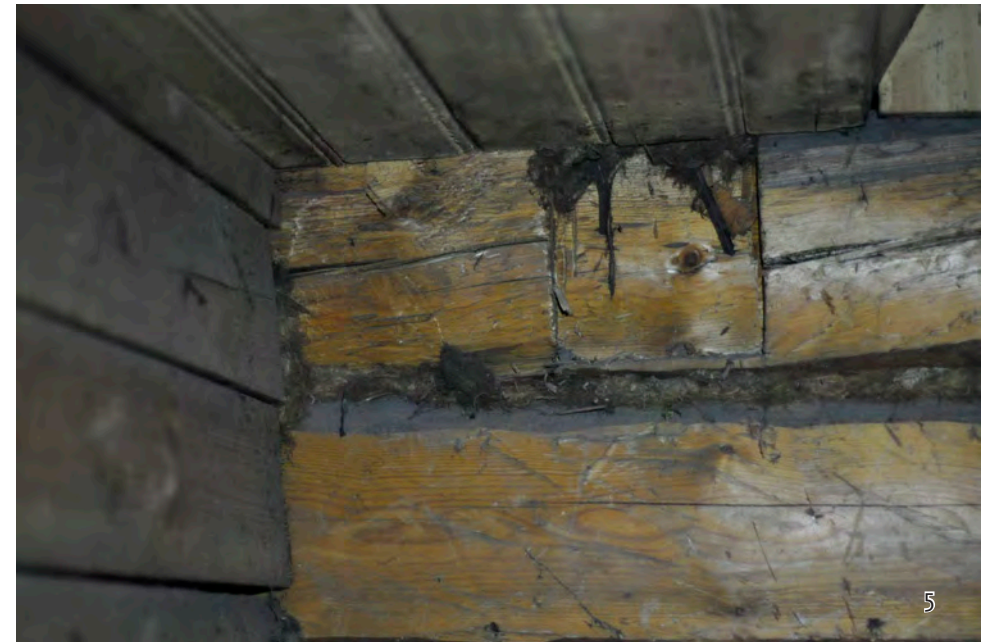
Kuva: Huone 301, vuoliaisen pään loveus hirsiseinässä, vuoden 1916 muutoksissa tehdyn porrasaukon kohdalla, on merkinä aiemmasta lattiarakenteesta ja sen suunnasta.
