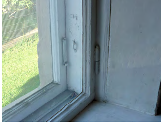
Vanhakantaisissa ikkunoissa karmien sisäsyryssä on koristehöyläykset. Sisäpuitteet ovat luultavasti uudemmat kuin ulkopuitteet, ja profiilitkin ovat erilaiset.
