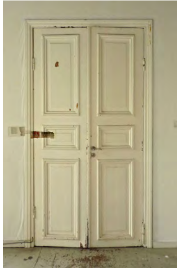
Kolmipeiliset pariovet, joissa keski-peili on matala, EO-4.
