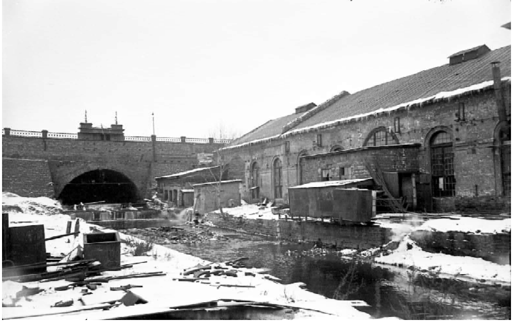
Общий вид зданий и цехов бывшего Екатеринбургского монетного двора. 1959 г. (ГАСО. Ф. Ф-1. Оп. 6. Д. 6388)
