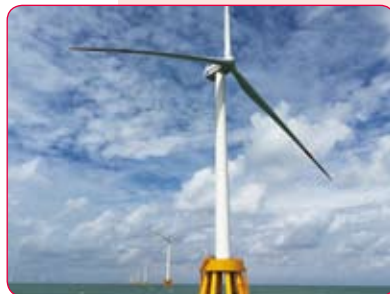
5MW海上风电机组
