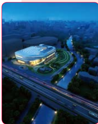
冬季运动管理中心综合训练馆
