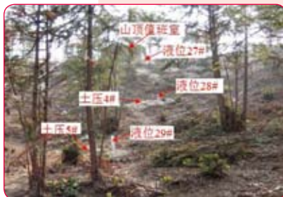
工艺实施现场
