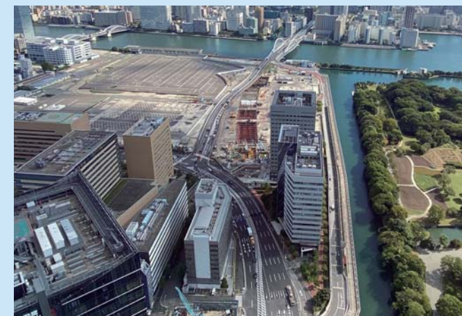
築地地区全体の状況 (R2.10)
