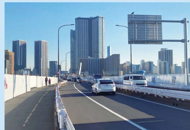
地上部道路の状況 (R2.12)
