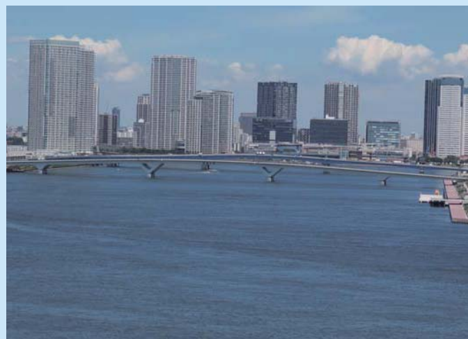
豊洲大橋の状況 (H28.6)
