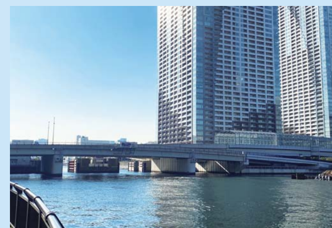
黎明大橋の状況 (R2.12)
