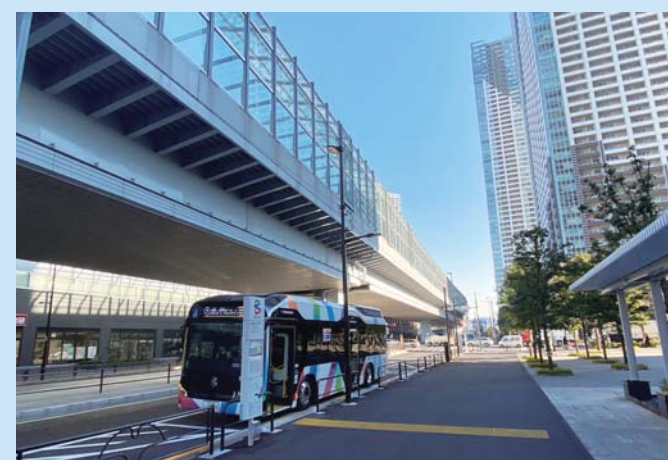
勝どき陸橋の状況 (R2.12)
