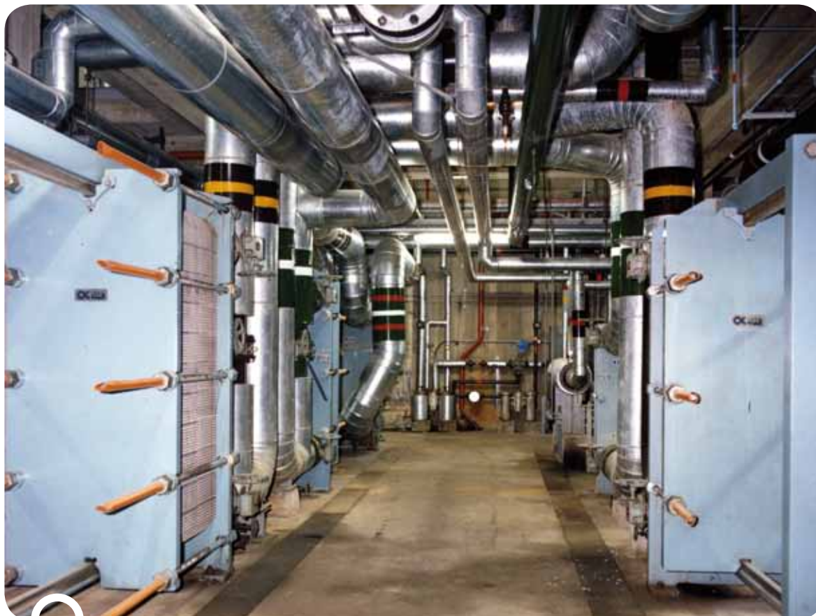
Centrale Le Vallette: scambiatori di calore
