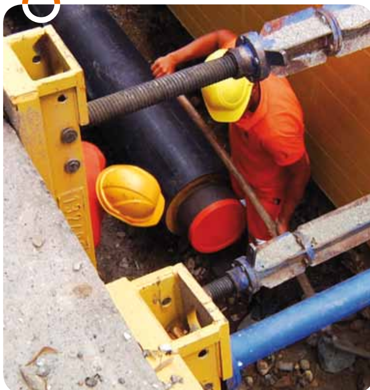
Posa reti di distribuzione del calore
