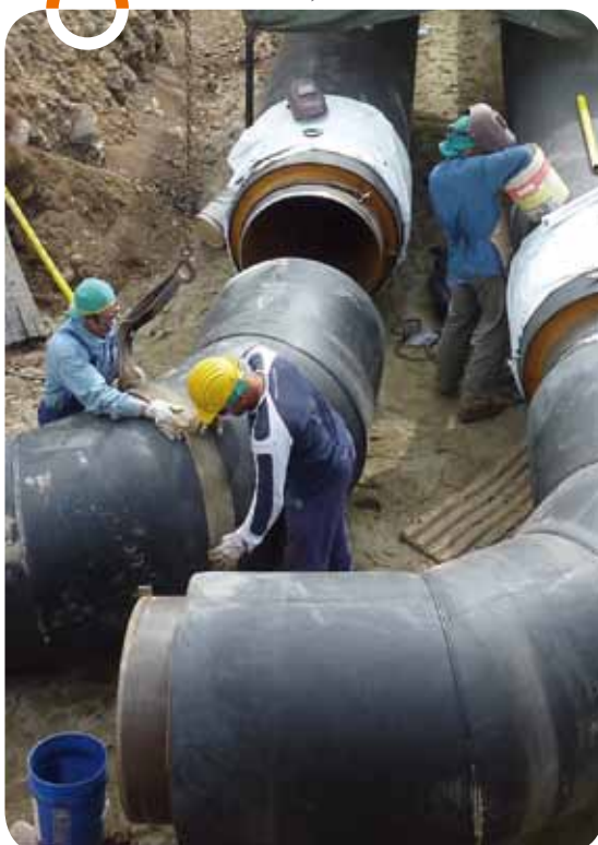
Posa reti di trasporto del calore
