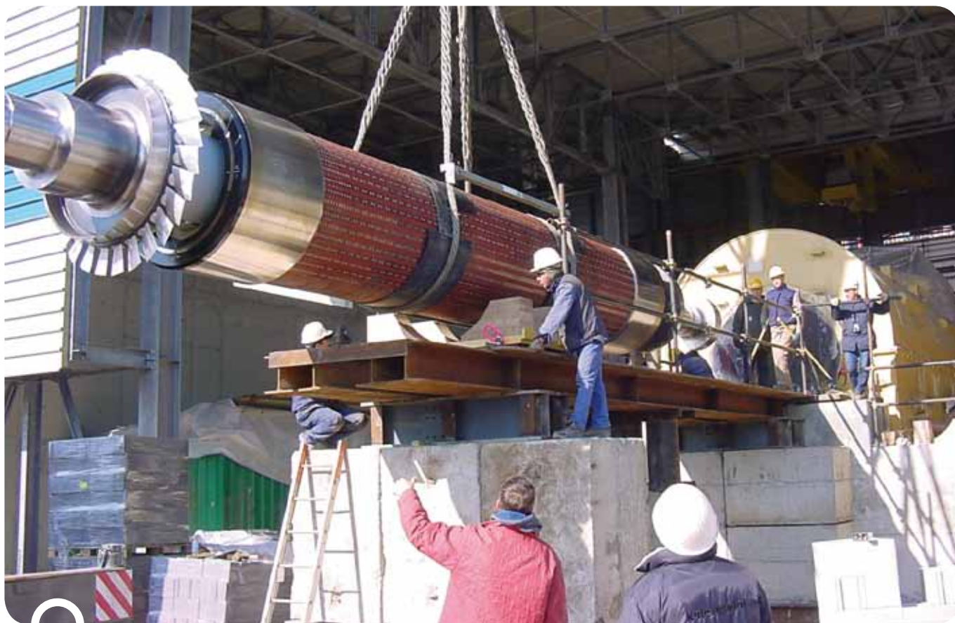
Centrale di Moncalieri: montaggio del rotore dell'alternatore del 3° GT
