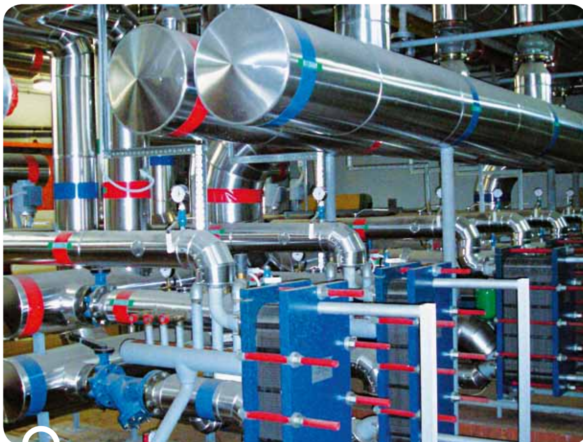
Scambiatori di calore
