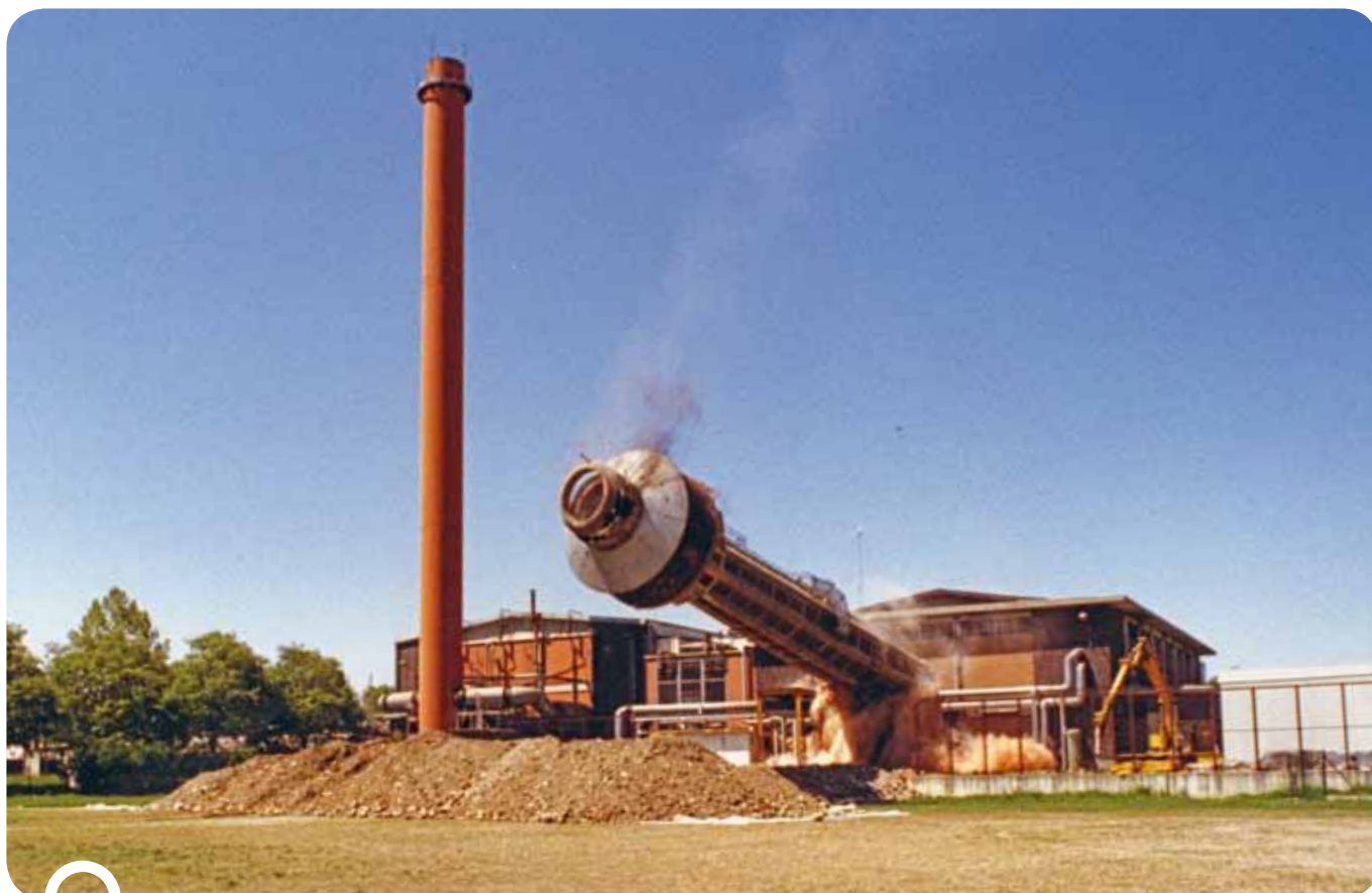
Centrale Le Vallette: demolizione del vecchio camino
