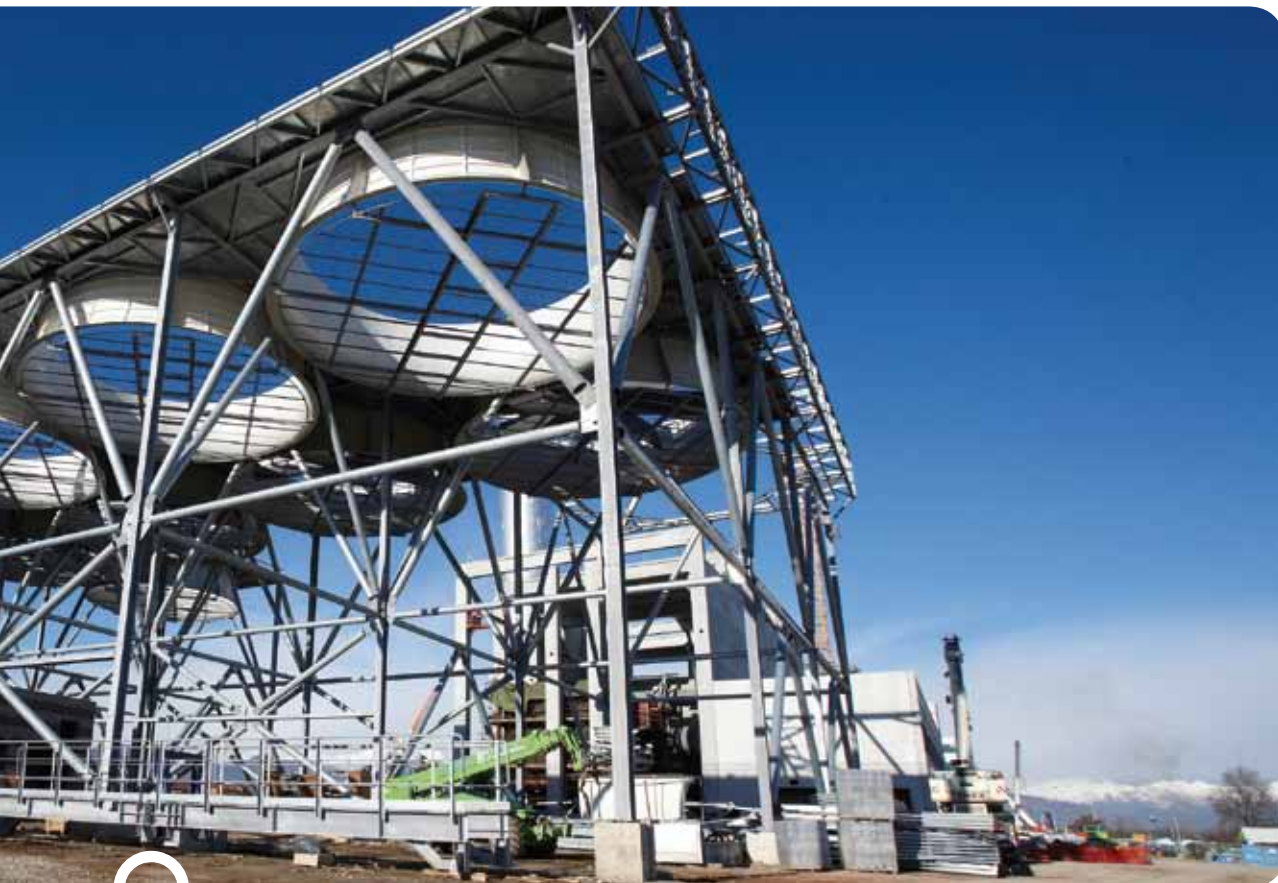
Centrale Torino Nord: proseguono i lavori. Nella foto la struttura dell'aeroterma
