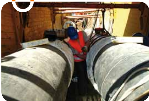
Posa reti teleriscaldamento
