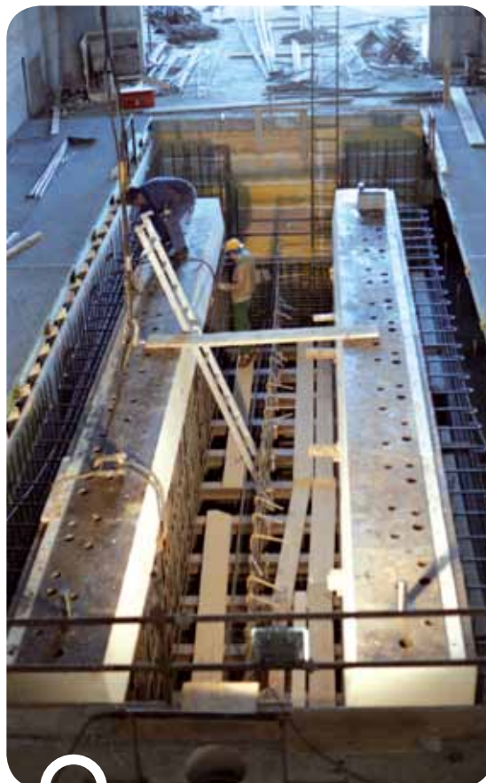
Centrale Mirafiori Nord: realizzazione basamenti
