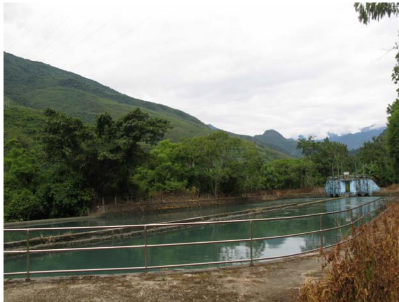
圖 99 初音電廠前沉砂池
