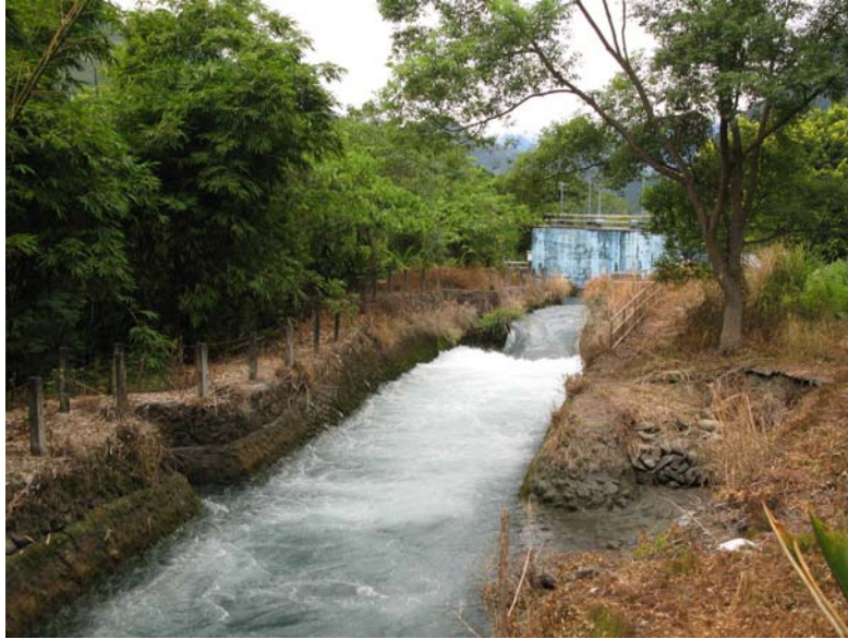
圖 100 沉砂池流水至水圳主幹線
