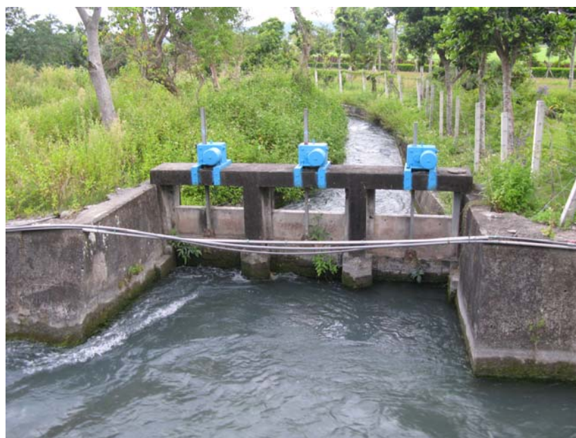
圖 108 水圳文化景觀：水閘門
