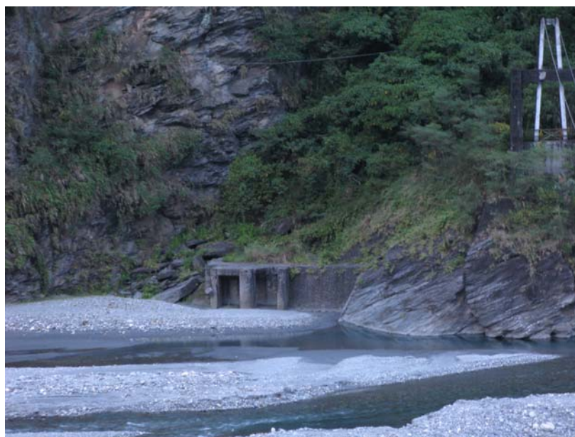
圖 48 日治時期改修的吉野圳取水口現況
