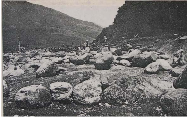
圖 28 吉野圳取入口施工情形
