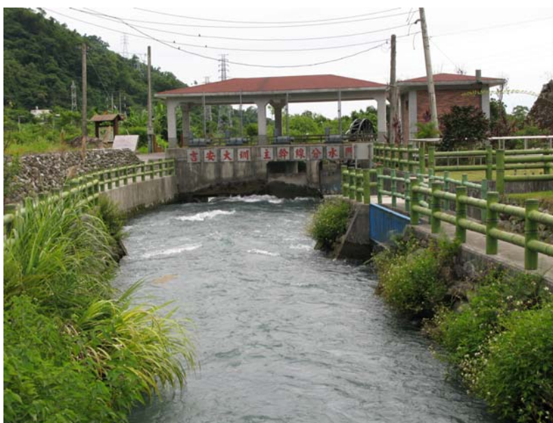
圖 54 吉安圳主幹線分水門
