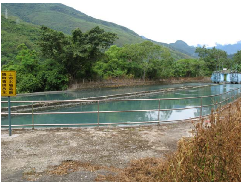
圖 50 初音電廠前集水池
