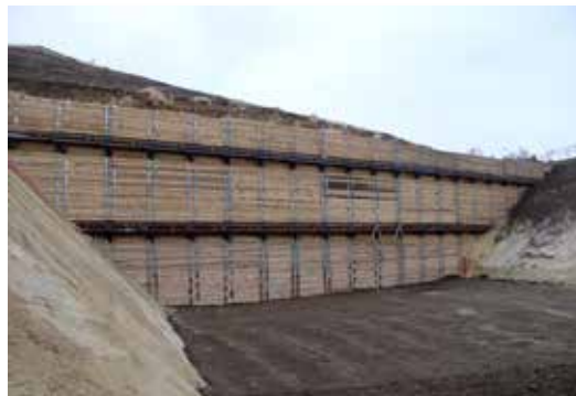
Анкерование „Берлинской стены“ и крепление досок клиновыми замками ТИТАН. Развязка с железнодорожным мостом, Бланкенбург Германия
