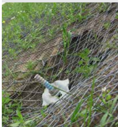
Нагельное крепление и облицовка торкрет-бетоном порталной стенки тоннеля Лалики в Польше
