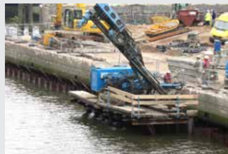
Реконструкция причального сооружения в г. Гамбурге, Германия. Установка анкеров ТИТАН с понтона, прикрепленного к новой шпунтовой стенке.
