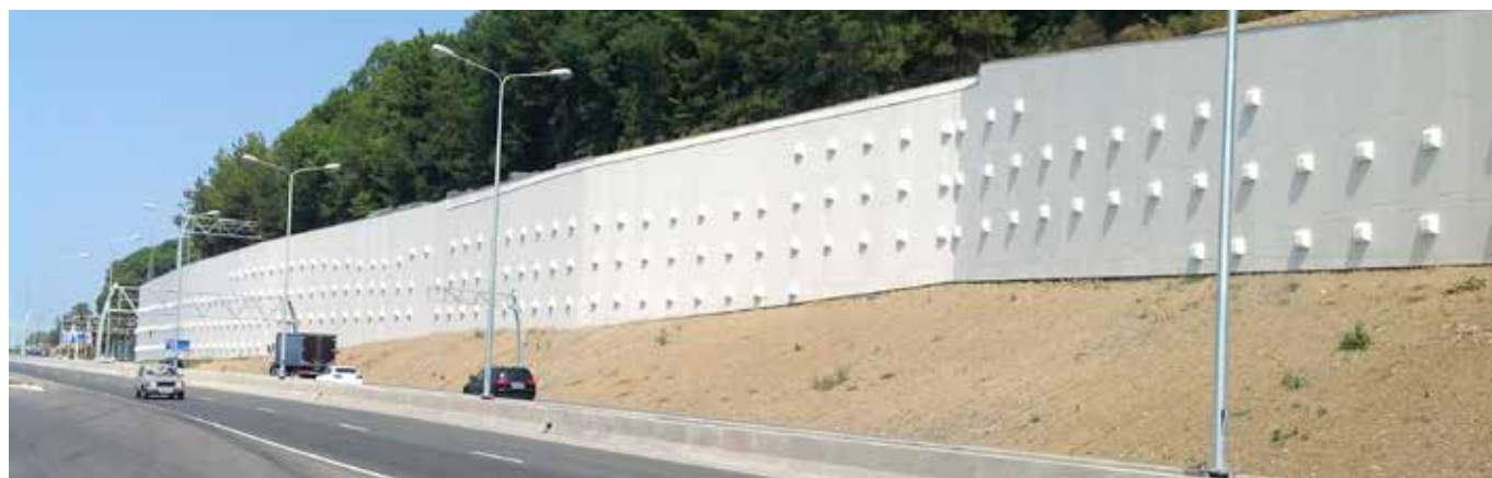
Крепление опорной стенки анкерными сваями ТИТАН вдоль Курортного Проспекта в Сочи, Россия
