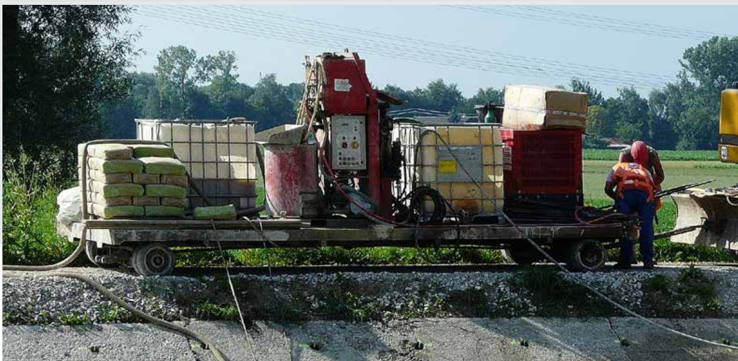
Типичная стройплощадка: экскаватор с навесной мачтой и насосная станция с расходными материалами на прицепе.
