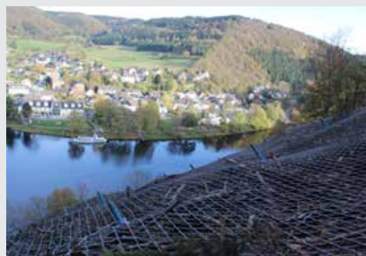
Крепление оползневого склона нагельным способом с сетями Геобругг, Айнрур ам Оберзее, Германия
