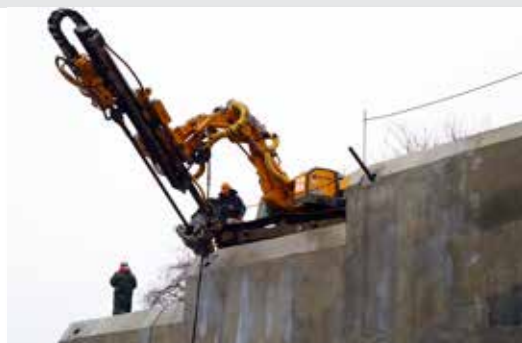
Крепление ж/б - опорной стены анкерными сваями ТИТАН в Сочи, Россия
