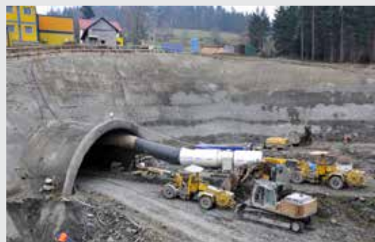
Нагельное крепление и облицовка торкрет-бетоном порталной стенки тоннеля Лалики в Польше
