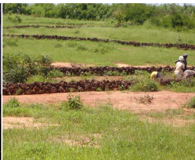
Photo 6 : Ouvrage en progression
