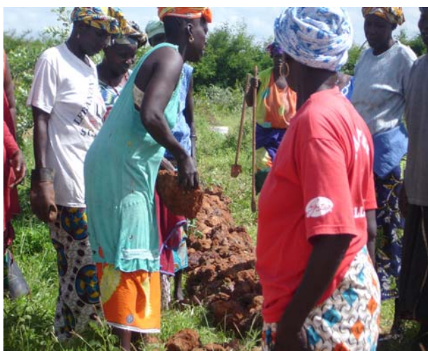
Photo 5 : Femmes construisant un cordon pierreux anti-érosif
