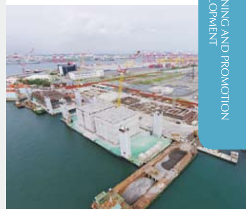
高雄港洲際碼頭二期施工－沉箱製作區 Port of Kaohsiung Intercontinental wharves Phase 2 – Caisson Area
